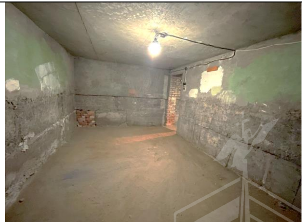
Фото 20. Типичное состояние Объекта оценки, помещение 8-Н
