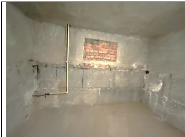
Фото 21. Типичное состояние Объекта оценки, помещение 8-Н
