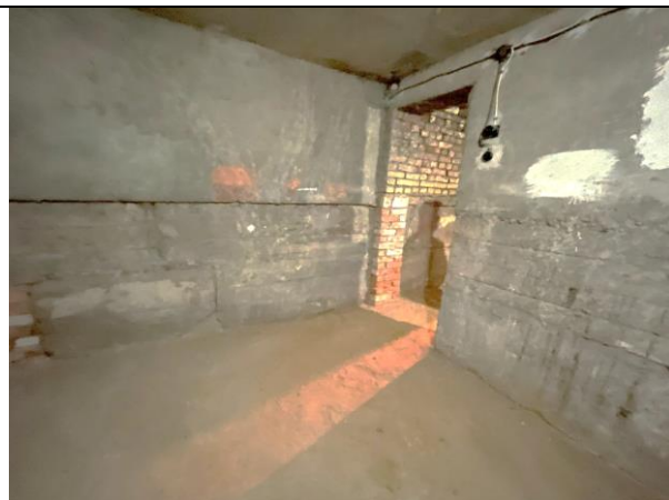
Фото 22. Типичное состояние Объекта оценки, помещение 8-Н
