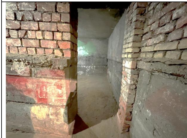
Фото 17. Типичное состояние Объекта оценки, помещение 8-Н
