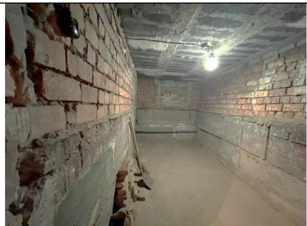
Фото 16. Типичное состояние Объекта оценки, помещение 8-Н
