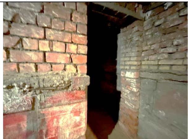
Фото 18. Типичное состояние Объекта оценки, помещение 8-Н
