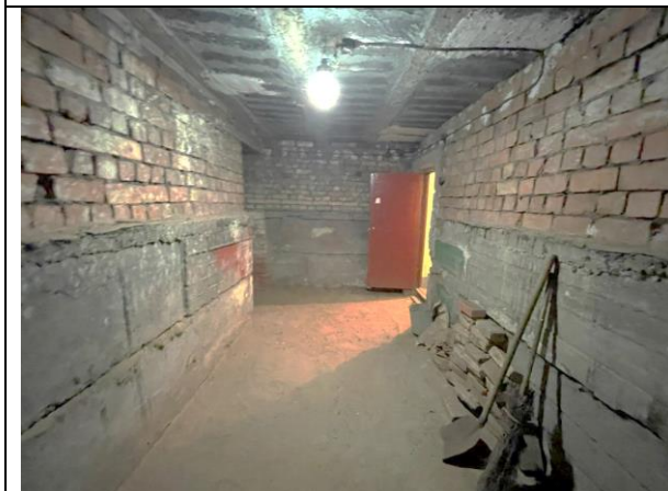
Фото 15. Типичное состояние Объекта оценки, помещение 8-Н
