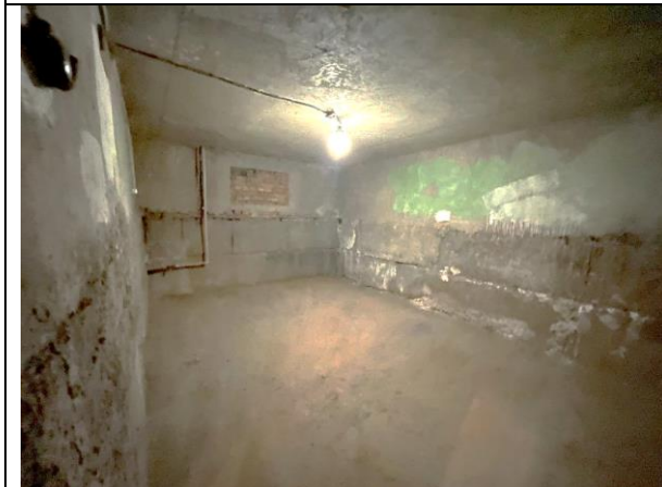
Фото 19. Типичное состояние Объекта оценки, помещение 8-Н
