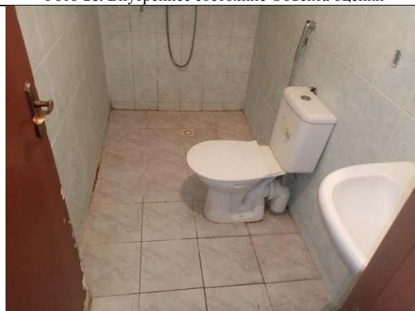
Фото 18. Внутреннее состояние Объекта оценки
