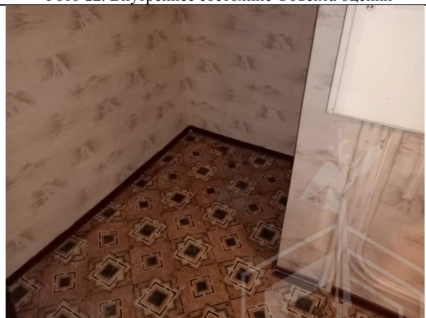
Фото 14. Внутреннее состояние Объекта оценки
