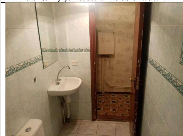
Фото 17. Внутреннее состояние Объекта оценки
