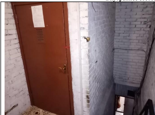
Фото 11. Внутреннее состояние Объекта оценки
