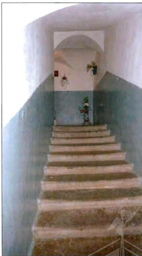
7. Корпус 3, литера В. Лестница (1-ЛК).
