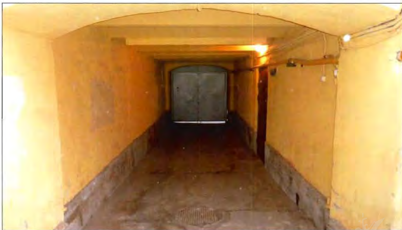
4. Корпус 3, литера В. Северный воротный проезд.
