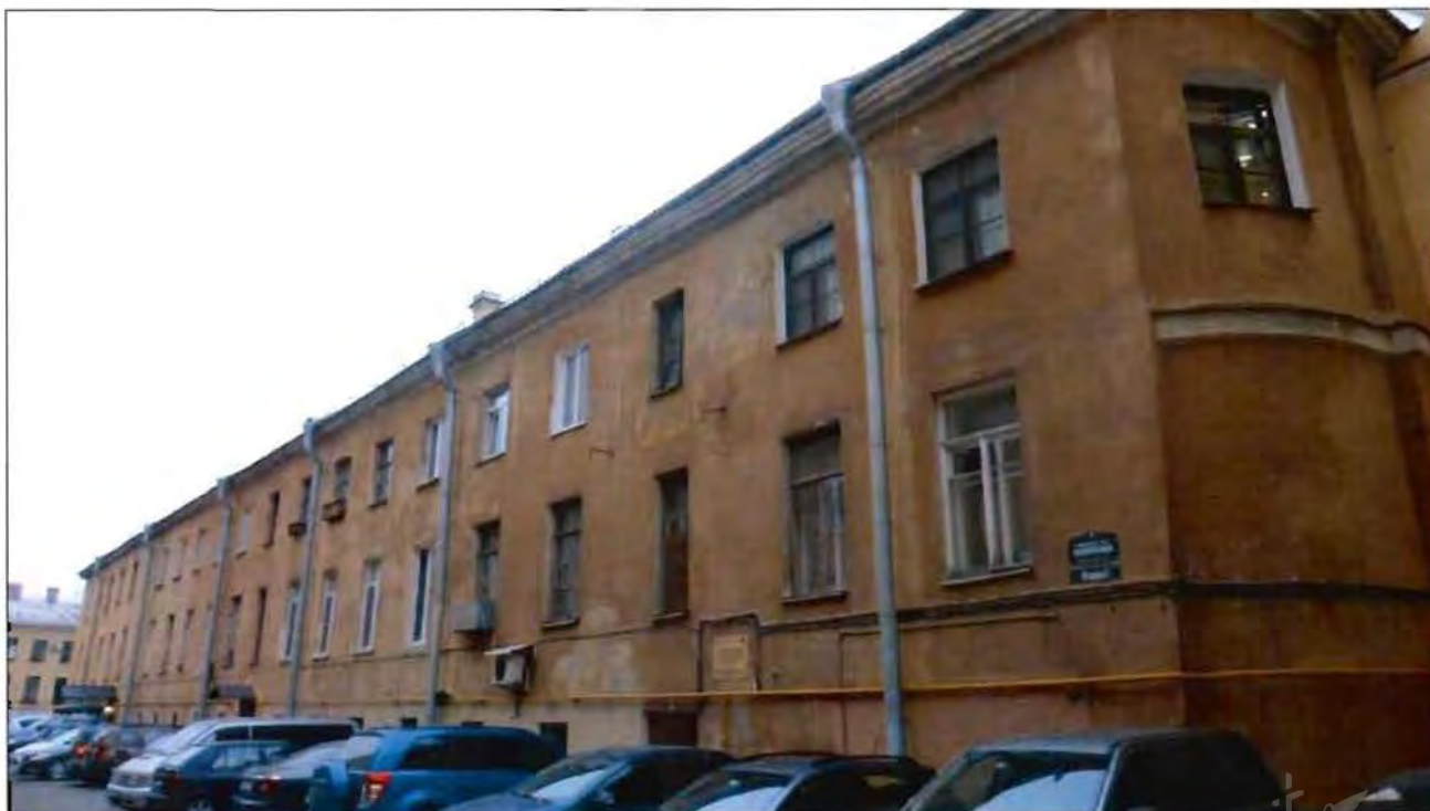
11. Корпус 2, литера Б. Вид с севера.
