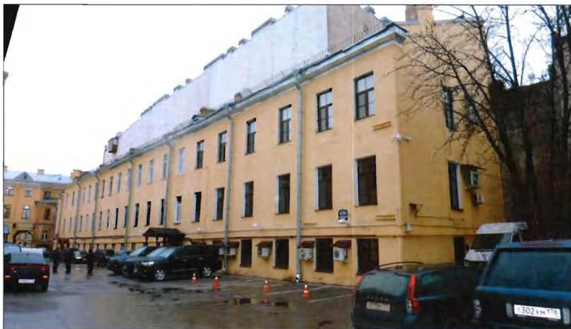
15. Корпус 8, литера Е. Общий вид с юга.
