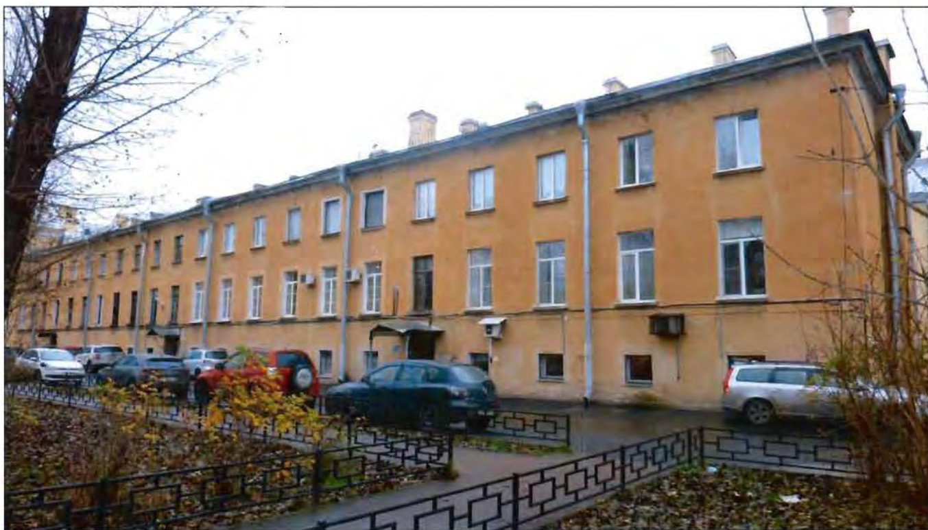
9. Корпус 2, литера Б. Вид с юга.
