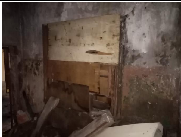
Фото № 9. Внутреннее состояние здания
