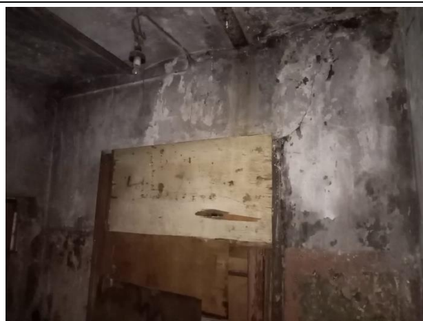
Фото № 14. Внутреннее состояние здания
