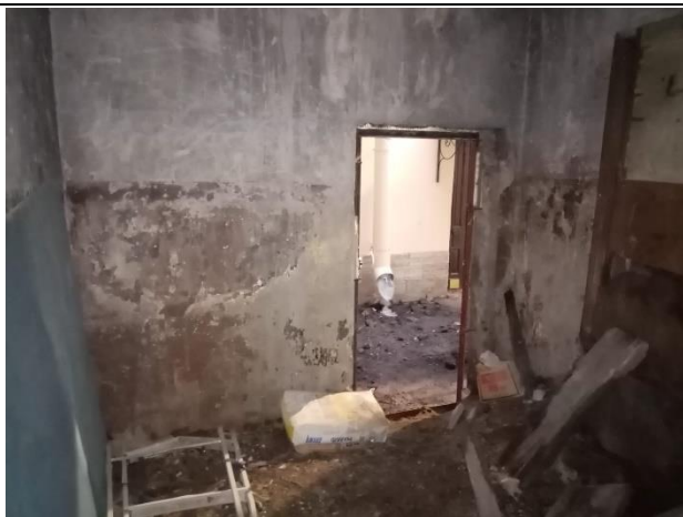
Фото № 11. Внутреннее состояние здания
