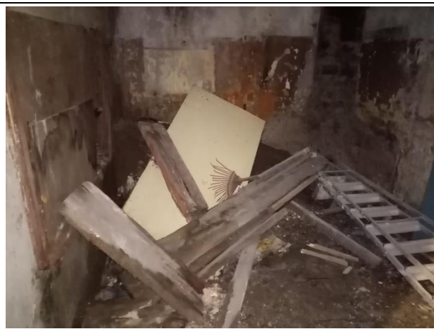
Фото № 12. Внутреннее состояние здания
