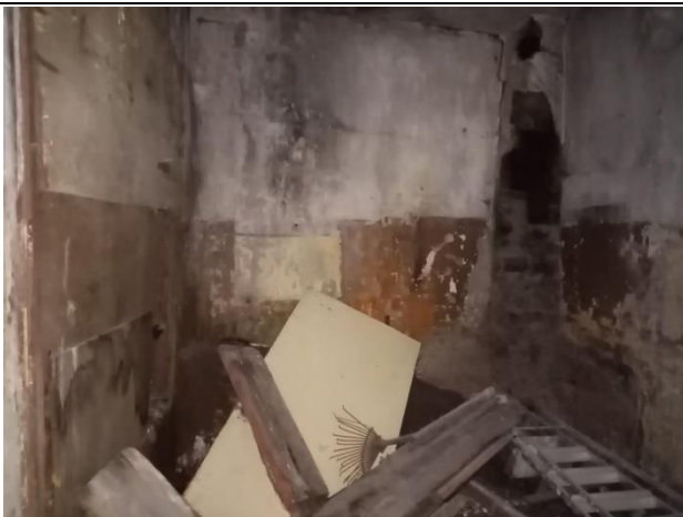
Фото № 13. Внутреннее состояние здания
