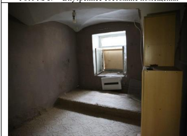
Фото № 19 – Внутреннее состояние помещения
