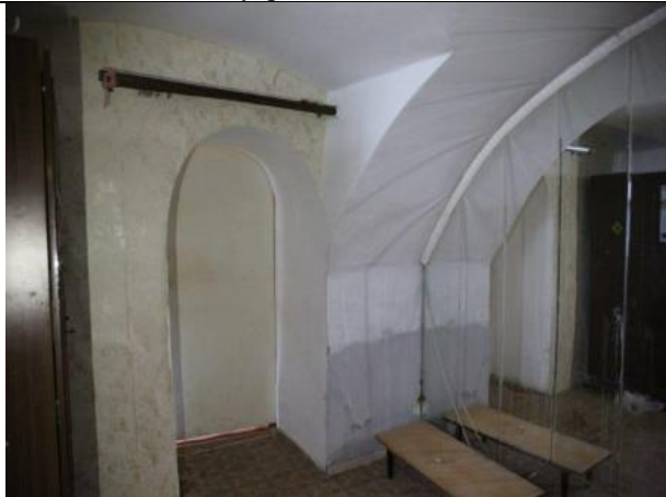
Фото № 25 – Внутреннее состояние помещения
