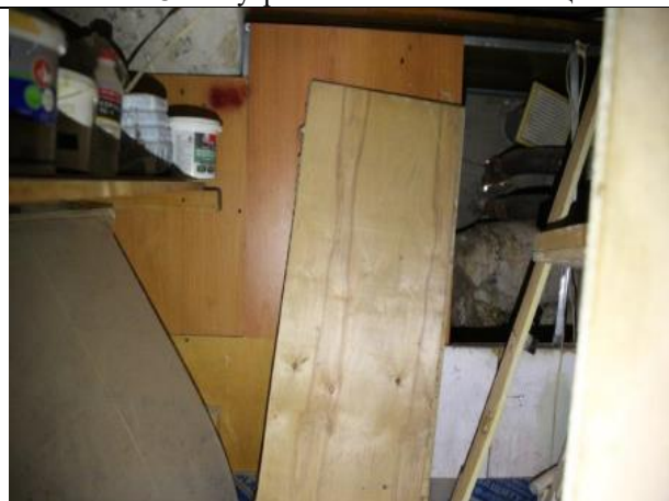
Фото № 10 – Внутреннее состояние помещения
