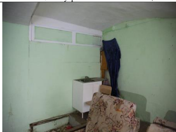
Фото № 28 – Внутреннее состояние помещения
