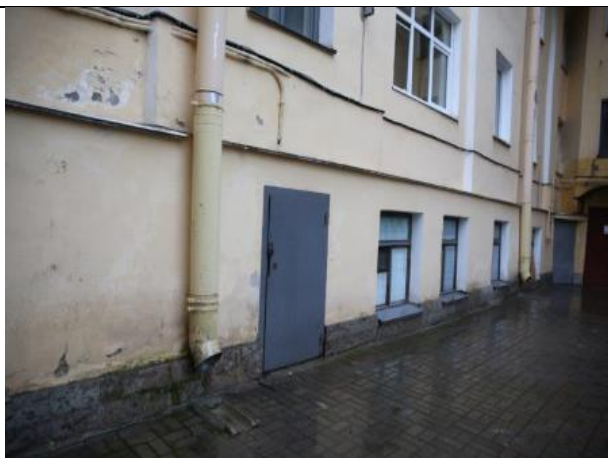
Фото № 5 – Вход в помещение
