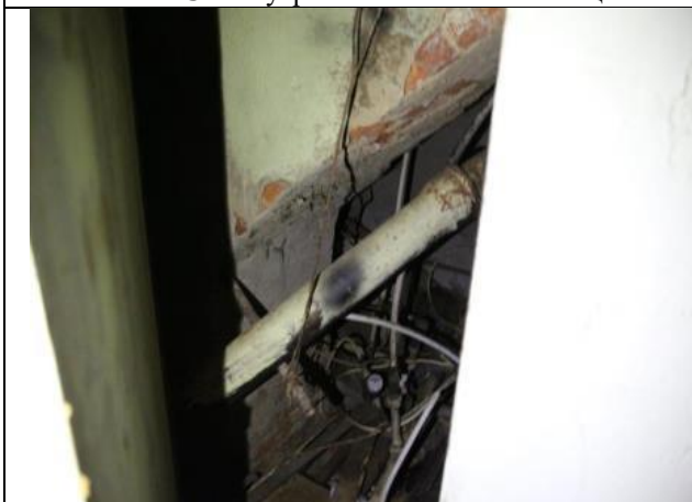
Фото № 17 – Внутреннее состояние помещения
