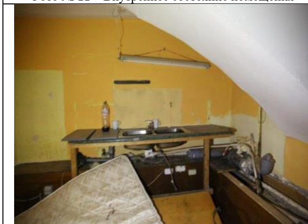
Фото № 13 – Внутреннее состояние помещения
