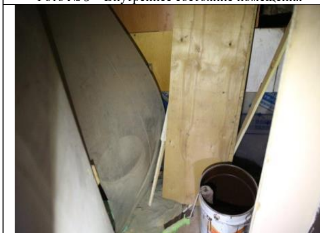
Фото № 11 – Внутреннее состояние помещения
