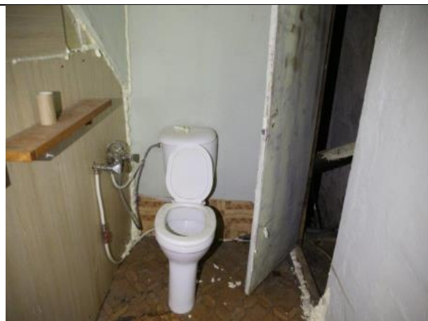
Фото № 16 – Внутреннее состояние помещения
