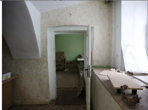
Фото № 26 – Внутреннее состояние помещения
