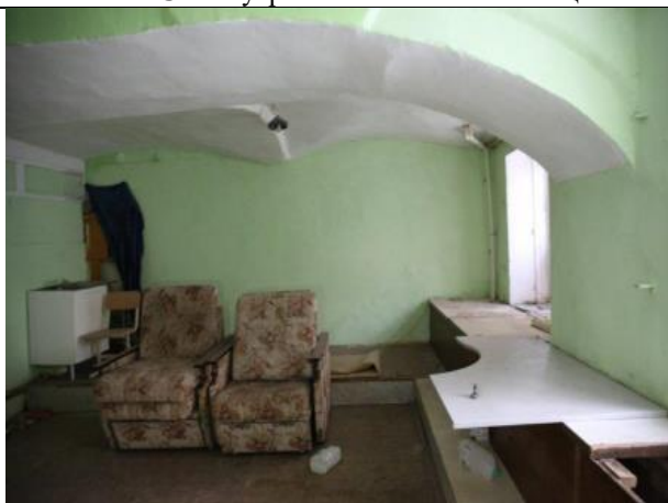
Фото № 27 – Внутреннее состояние помещения
