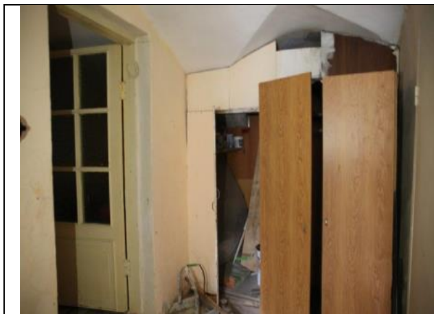
Фото № 7 – Внутреннее состояние помещения
