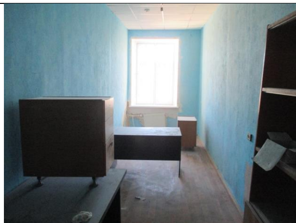
Фото № 30 – Внутреннее состояние помещения 13-Н
