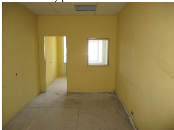
Фото № 50 – Внутреннее состояние помещения 12-Н
