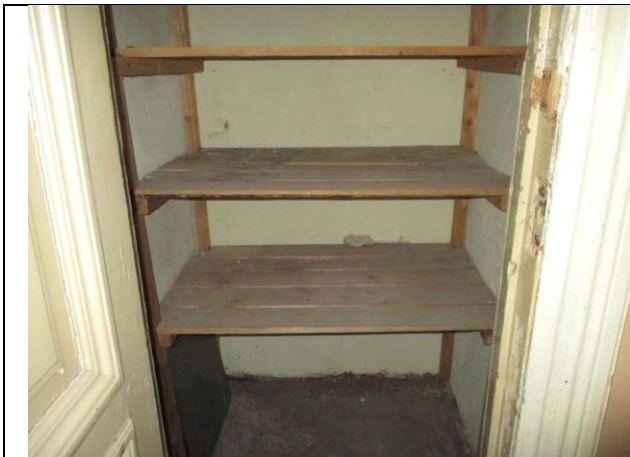
Фото № 53 – Внутреннее состояние помещения 12-Н
