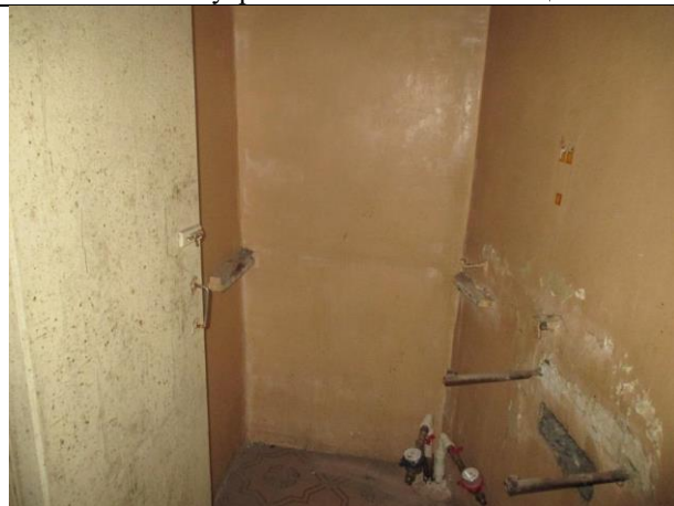
Фото № 58 – Внутреннее состояние помещения 12-Н
