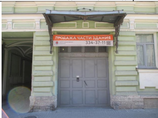
Фото № 7 – Вход в помещение с улицы
