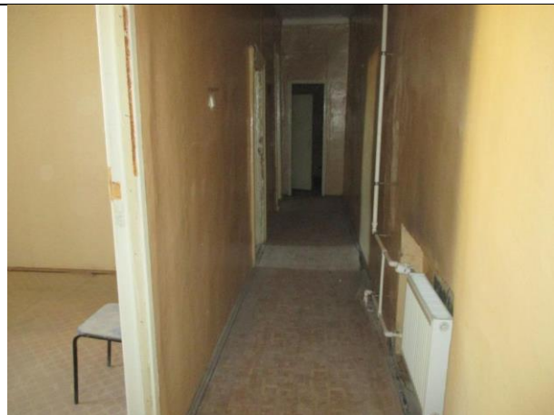
Фото № 54 – Внутреннее состояние помещения 12-Н
