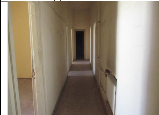
Фото № 18 – Внутреннее состояние помещения 10-Н
