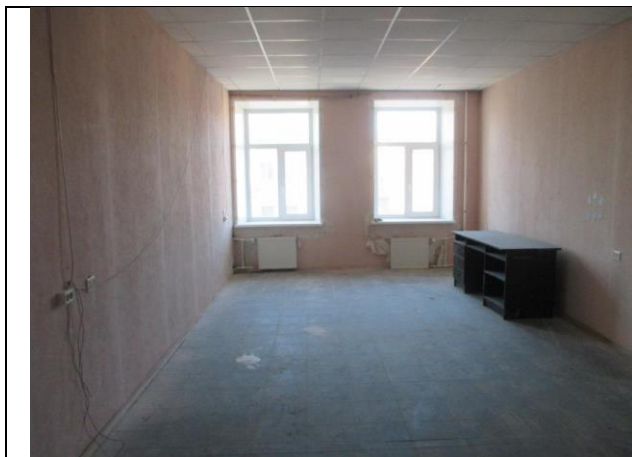
Фото № 37 – Внутреннее состояние помещения 13-Н
