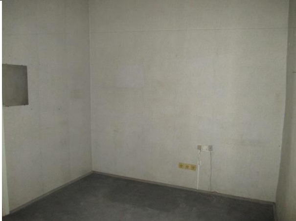
Фото № 23 – Внутреннее состояние помещения 10-Н
