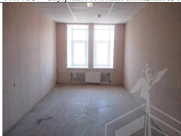
Фото № 36 – Внутреннее состояние помещения 13-Н
