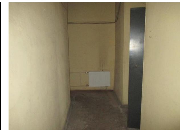
Фото № 14 – Внутреннее состояние помещения 10-Н
