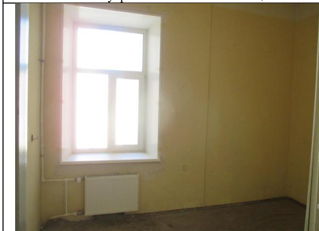
Фото № 19 – Внутреннее состояние помещения 10-Н
