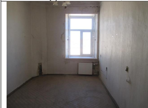
Фото № 57 – Внутреннее состояние помещения 12-Н
