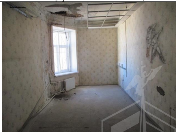
Фото № 60 – Внутреннее состояние помещения 12-Н
