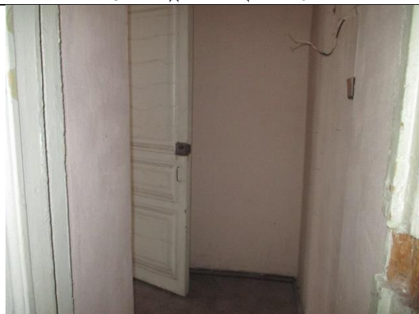
Фото № 10 – Внутреннее состояние помещения 10-Н
