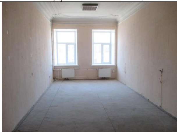
Фото № 11 – Внутреннее состояние помещения 10-Н
