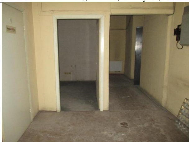
Фото № 9 – Внутреннее состояние помещения 10-Н
