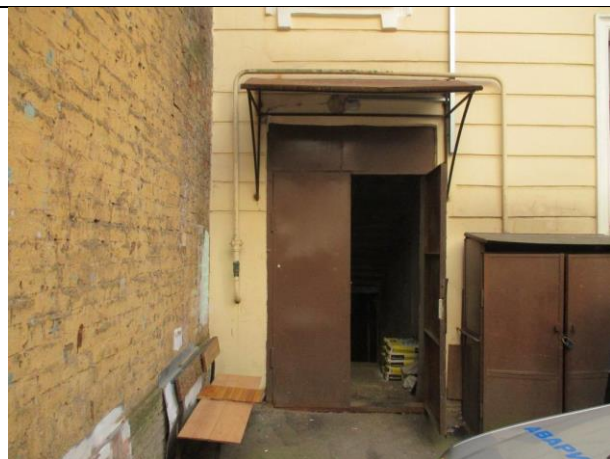
Фото № 6 – Вход в помещение со двора
