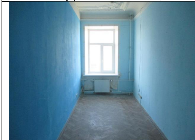
Фото № 39 – Внутреннее состояние помещения 13-Н
