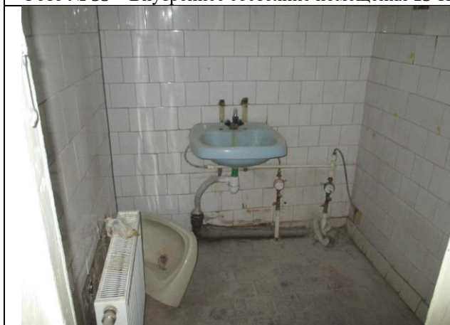
Фото № 35 – Внутреннее состояние помещения 13-Н
