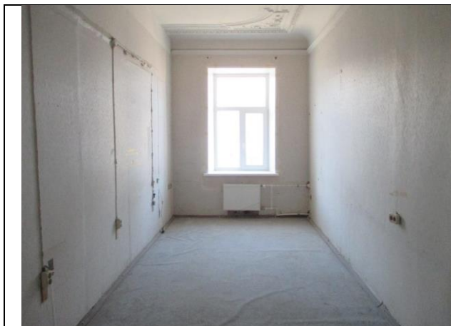
Фото № 13 – Внутреннее состояние помещения 10-Н
