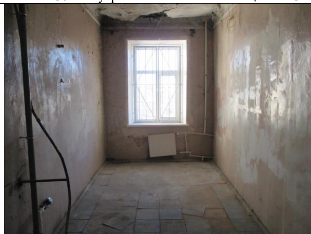
Фото № 32 – Внутреннее состояние помещения 13-Н
