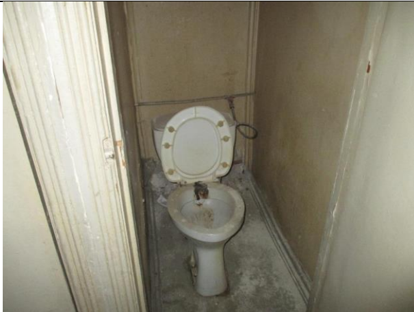
Фото № 21 – Внутреннее состояние помещения 10-Н
