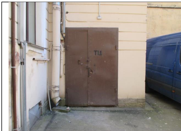
Фото № 5 – Вход в помещение со двора
