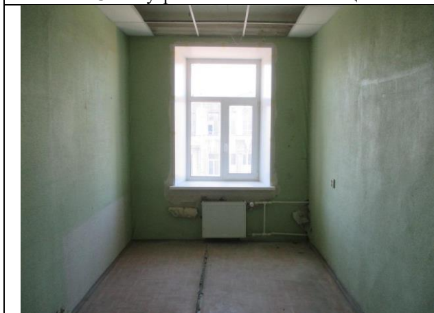
Фото № 47 – Внутреннее состояние помещения 12-Н
