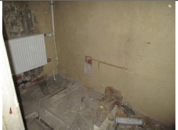
Фото № 22 – Внутреннее состояние помещения 10-Н
