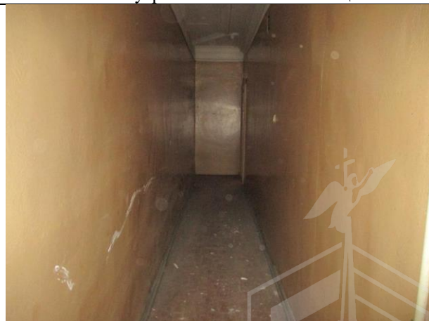
Фото № 52 – Внутреннее состояние помещения 12-Н
