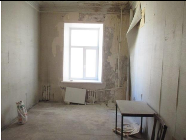
Фото № 25 – Внутреннее состояние помещения 10-Н
