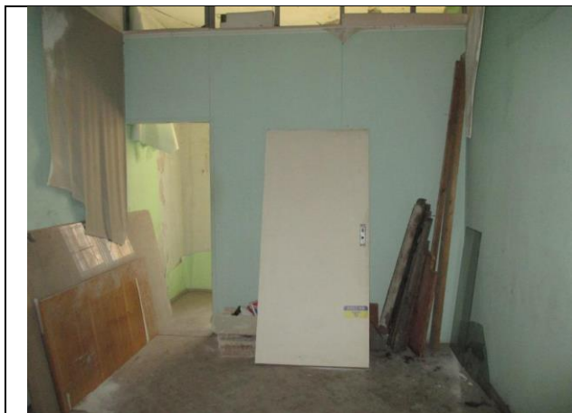
Фото № 61 – Внутреннее состояние помещения 12-Н
