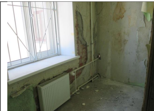
Фото № 62 – Внутреннее состояние помещения 12-Н
