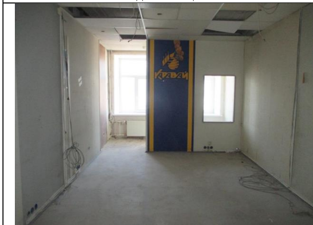
Фото № 43 – Внутреннее состояние помещения 12-Н
