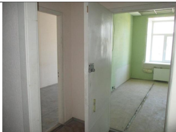
Фото № 46 – Внутреннее состояние помещения 12-Н
