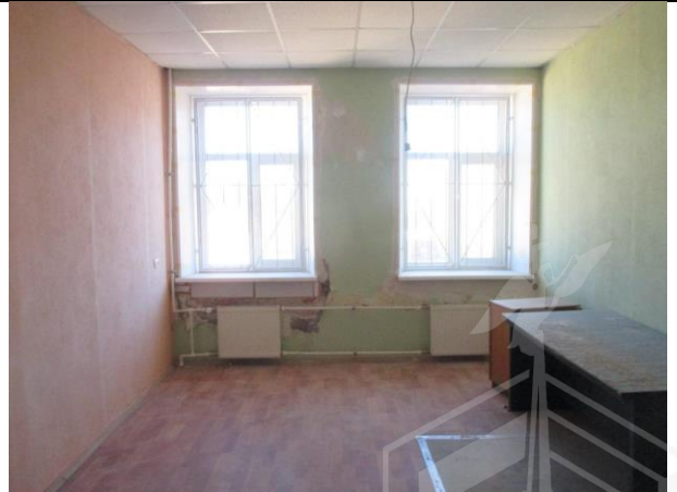
Фото № 28 – Внутреннее состояние помещения 13-Н
