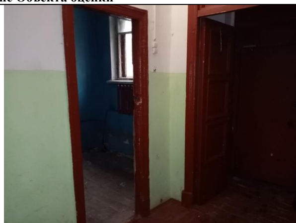
Фото 6. Внутреннее состояние Объекта оценки
