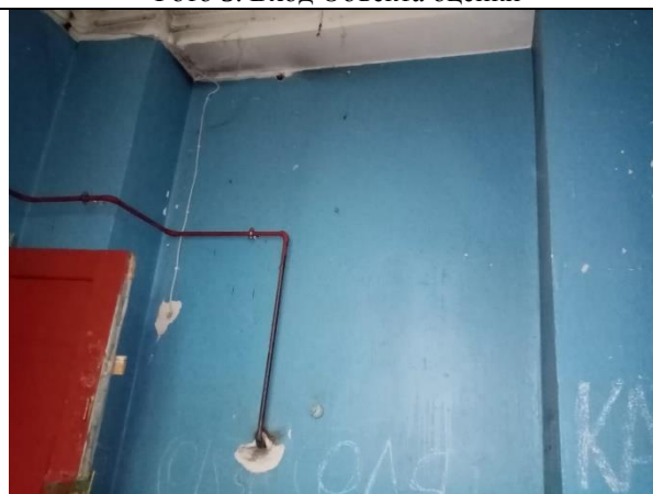
Фото 7. Внутреннее состояние Объекта оценки
