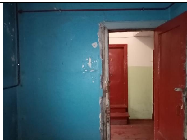
Фото 10. Внутреннее состояние Объекта оценки
