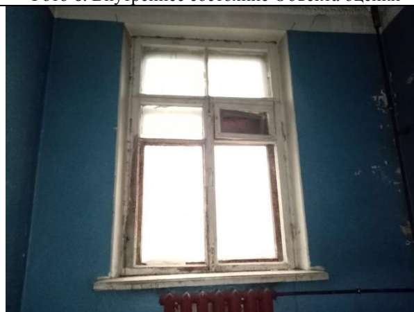
Фото 8. Внутреннее состояние Объекта оценки
