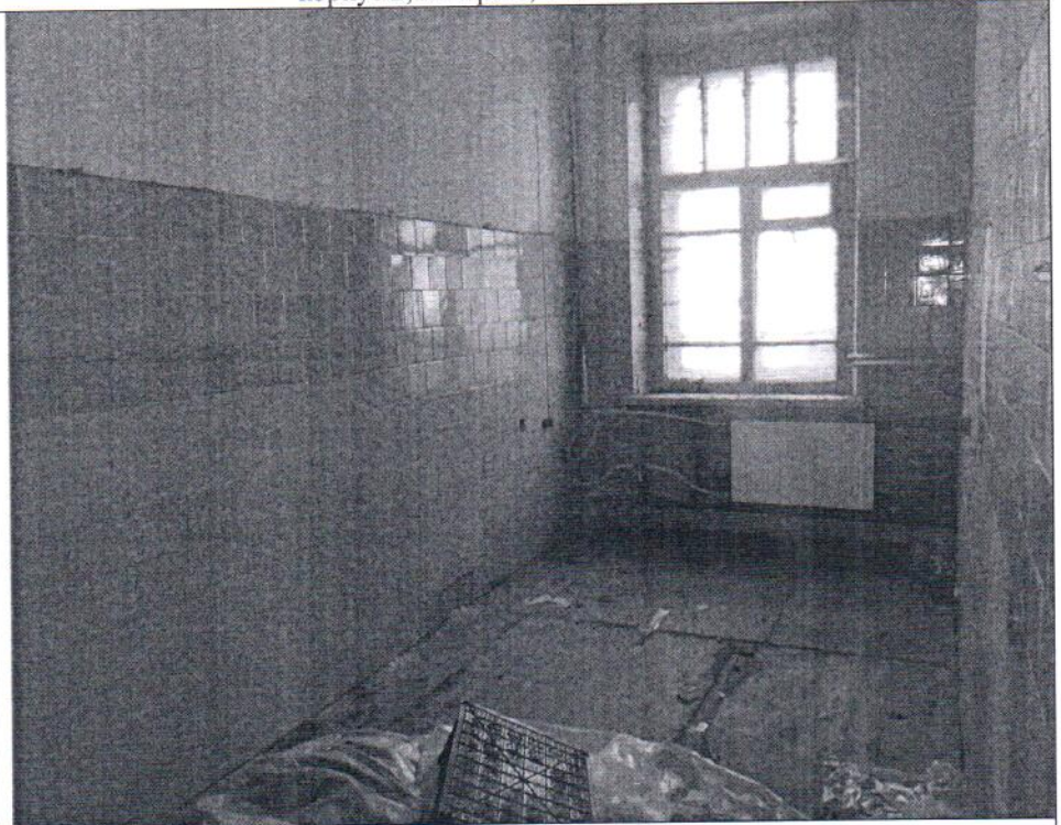
Описание: Вид внутри Объекта
