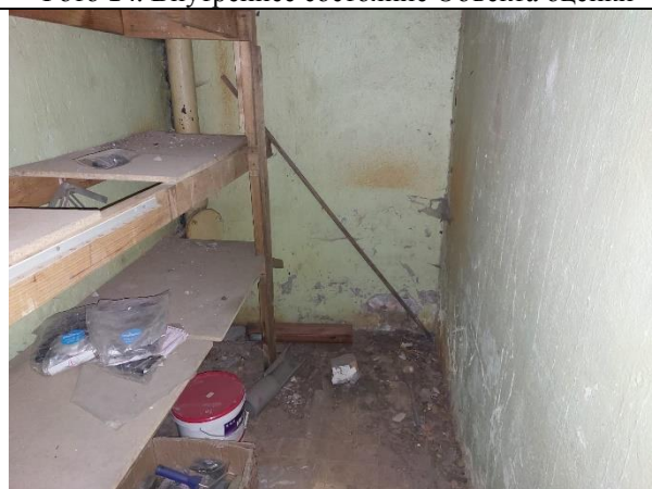
Фото 16. Внутреннее состояние Объекта оценки
