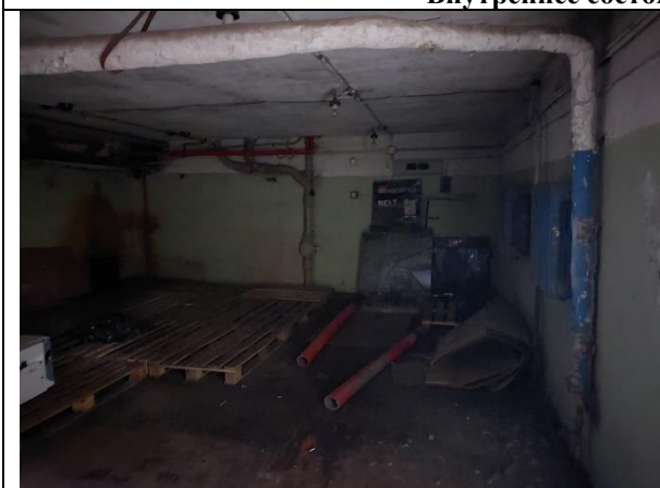
Фото 9. Внутреннее состояние Объекта оценки
