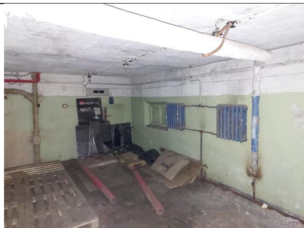
Фото 14. Внутреннее состояние Объекта оценки
