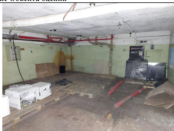
Фото 10. Внутреннее состояние Объекта оценки
