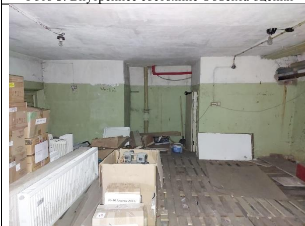
Фото 11. Внутреннее состояние Объекта оценки
