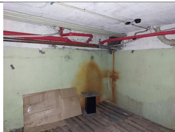
Фото 13. Внутреннее состояние Объекта оценки
