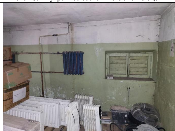
Фото 15. Внутреннее состояние Объекта оценки
