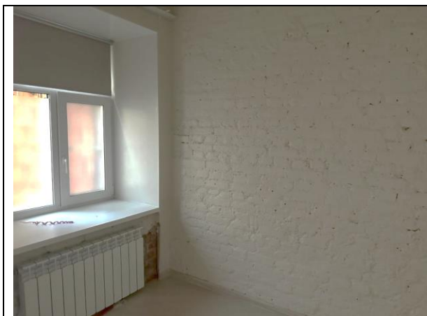
Фото 15. Типичное состояние Объекта оценки
