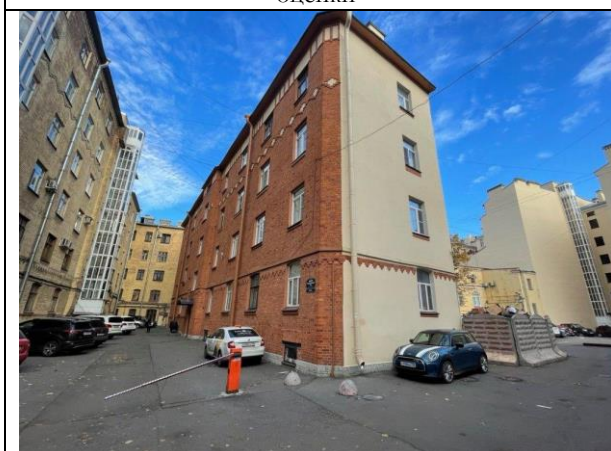
Фото 19. Вид здания расположения Объекта оценки
