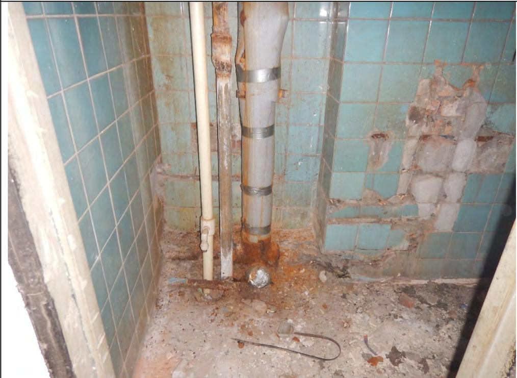
В ч.п. 7 Объекта демонтировано сантехническое оборудование
