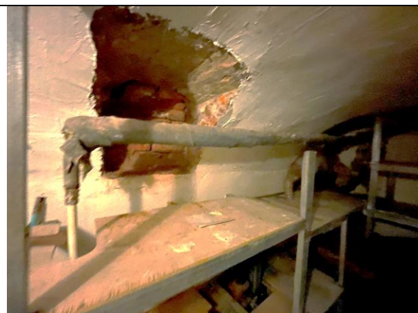
Фото 24. Типичное состояние Объекта оценки
