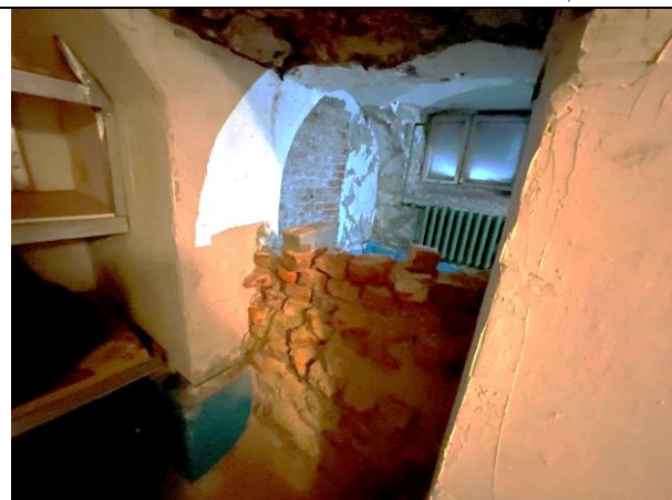
Фото 26. Типичное состояние Объекта оценки
