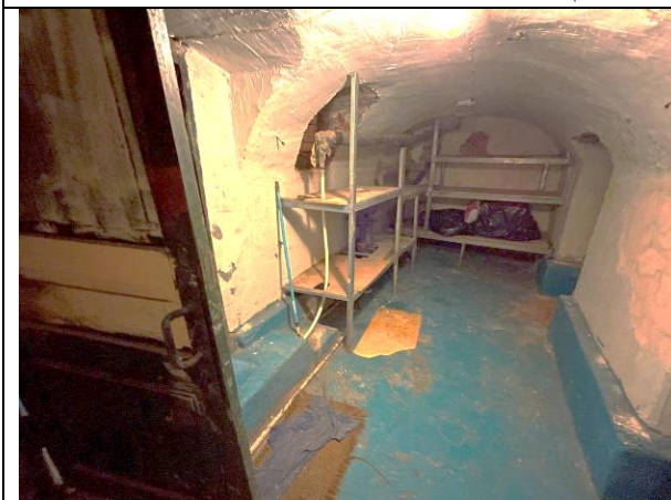
Фото 25. Типичное состояние Объекта оценки
