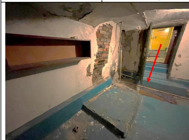
Фото 21. Типичное состояние Объекта оценки
