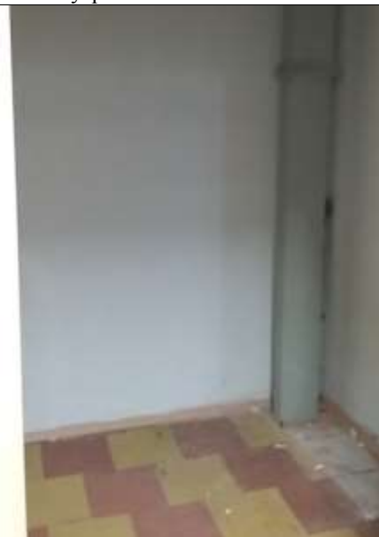
Фото 12. Внутреннее состояние Объекта оценки
