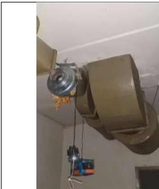
Фото 13. Внутреннее состояние Объекта оценки
