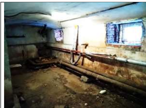
Фото 9. Внутреннее состояние Объекта оценки
