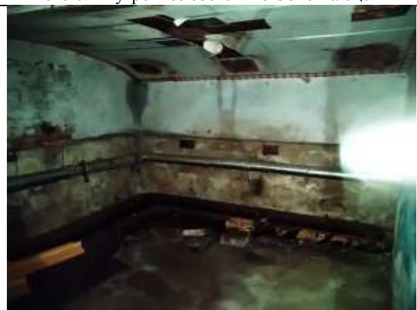
Фото 8. Внутреннее состояние Объекта оценки
