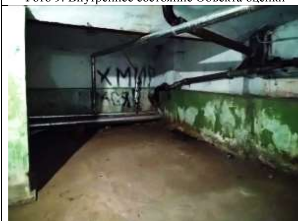
Фото 11. Внутреннее состояние Объекта оценки
