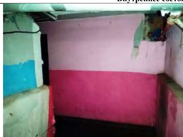
Фото 5. Внутреннее состояние Объекта оценки
