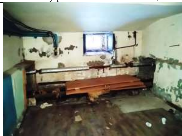
Фото 7. Внутреннее состояние Объекта оценки
