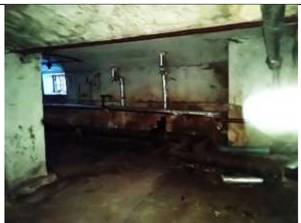
Фото 10. Внутреннее состояние Объекта оценки
