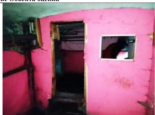
Фото 6. Внутреннее состояние Объекта оценки
