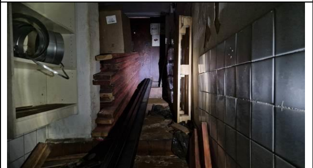
Фото 36. Типичное состояние Объекта оценки
