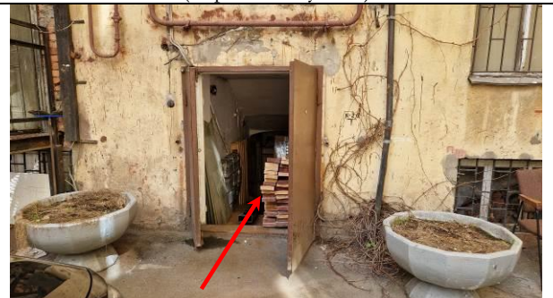
Фото 26. Вход со двора
