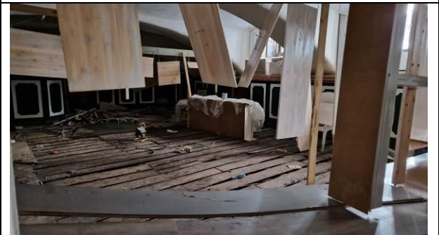
Фото 34. Типичное состояние Объекта оценки
