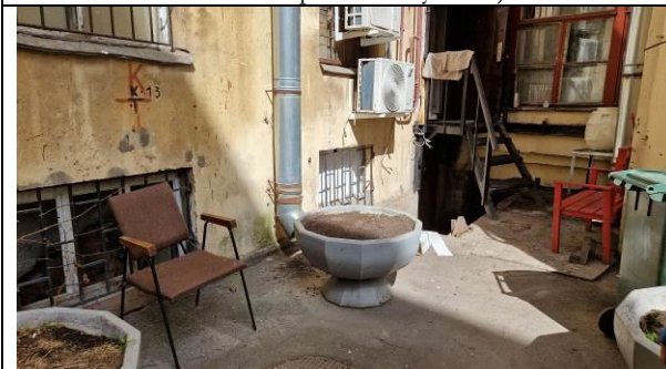
Фото 27. Вход со двора
