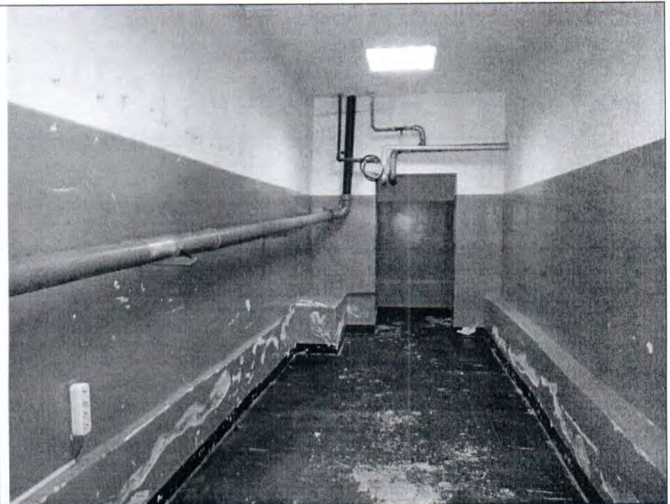
Описание: Вид внутри Объекта
