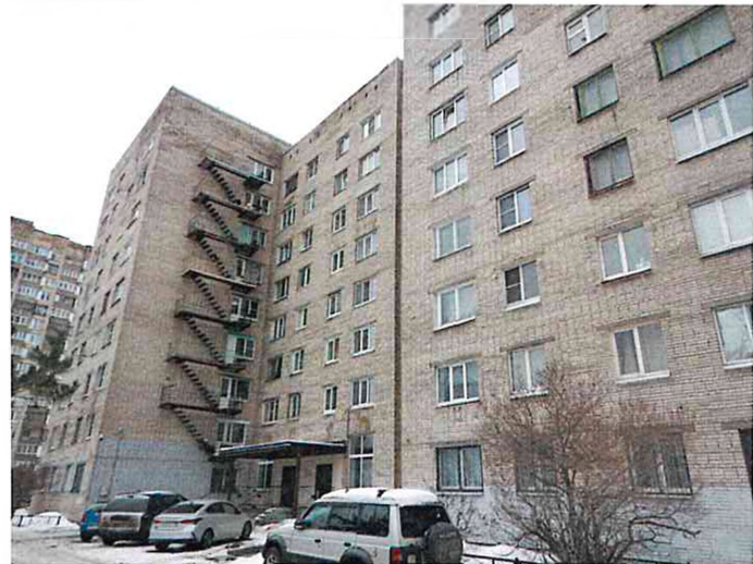
Фото №3 (вход отдельный с улицы)
