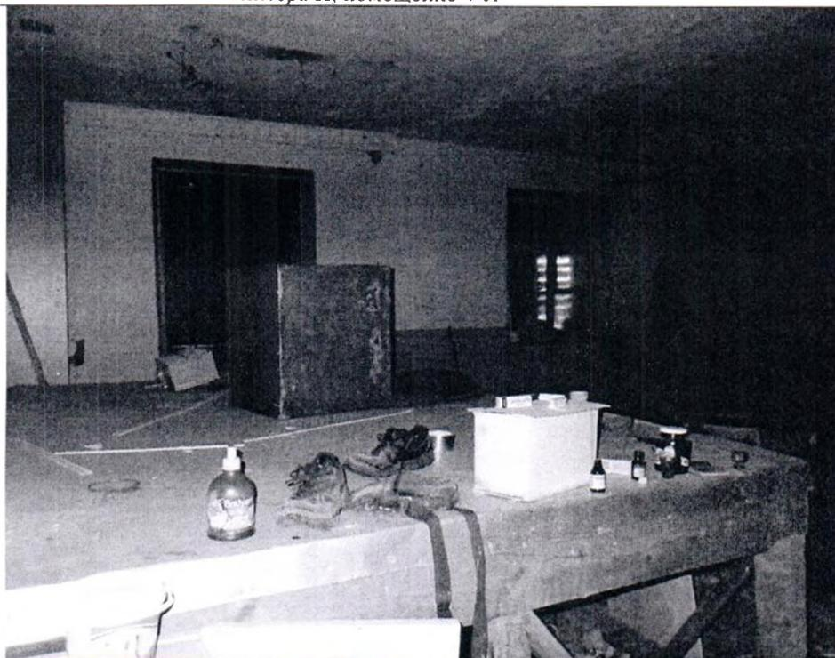
Описание: Вид внутри Объекта (в ч.п. 6 защит оконный проем; между ч.п. 1, ч.п. 6, ч.п. 7 снесены перегородки)
