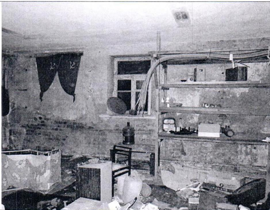
Описание: Вид внутри Объекта (в ч.п. 7 защит оконный проем; между ч.п. 1, ч.п. 6, ч.п. 7 снесены перегородки)
