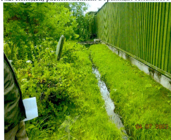
Фото №4. Водоотводная канава, расположенная вдоль южной границы земельного участка
