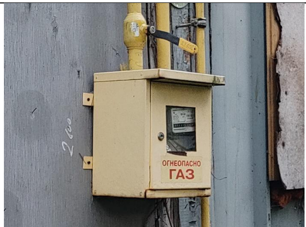
Фото 14. Вид Объекта оценки (ГРП на территории)
