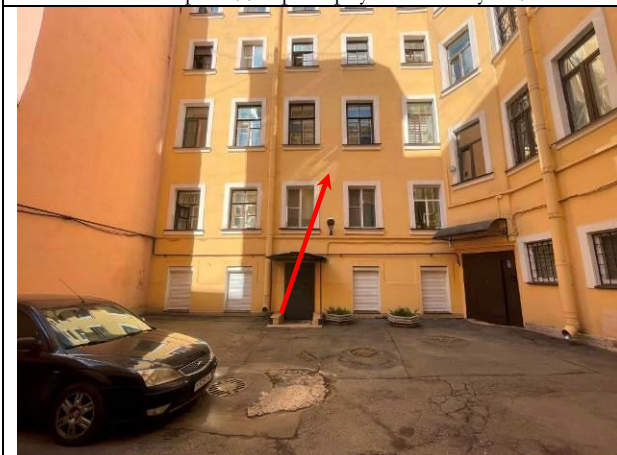
Фото 21. Вид здания расположения Объекта оценки
