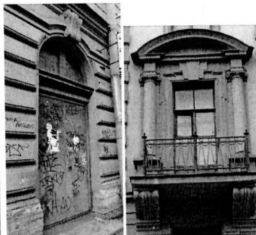
три исторических балконных проема – местоположение (в уровне третьего этажа по 7, 19, 31 осям), габариты, конфигурация;
