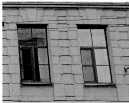
оформление оконных проемов третьего этажа – профилированные наличники с веерными замковыми камнями и прямыми сандриками, прямоугольные филенки в подоконном пространстве;
