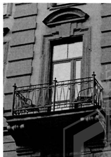
оформление балкона (по 19 оси) – два кронштейна, профилированный наличник с веерным замковым камнем и лучковым сандриком;
