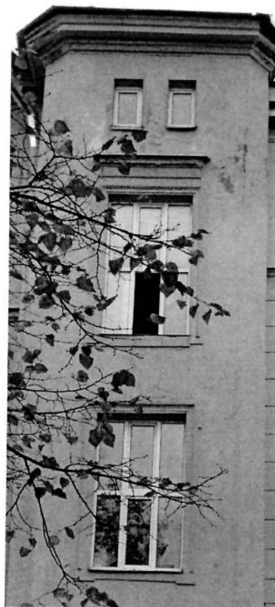
профилированный раскрепованный карниз под оконными проемами второго этажа;
