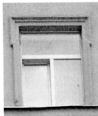
оформление оконных проемов третьего этажа – профилированные наличники;
