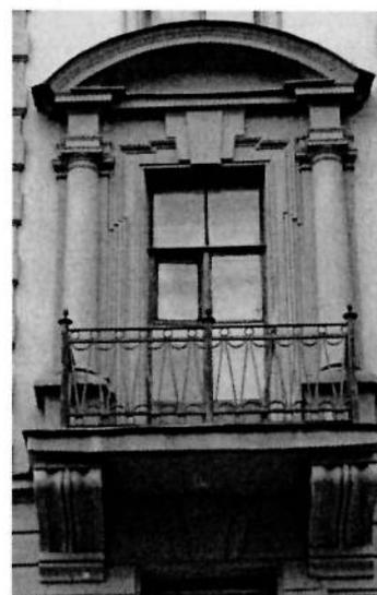
оформление балконов (по 7, 31 осям) – два кронштейна, портал, завершенный лучковым фронтоном с двумя пилястрами и двумя полуколоннами на прямоугольных основаниях, профилированный наличник с веерным замковым камнем;
