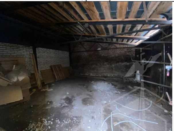
Фото № 8 – Внутреннее состояние помещения
