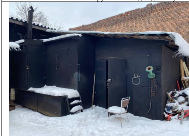
Фото № 3 – Вход в помещение со двора
