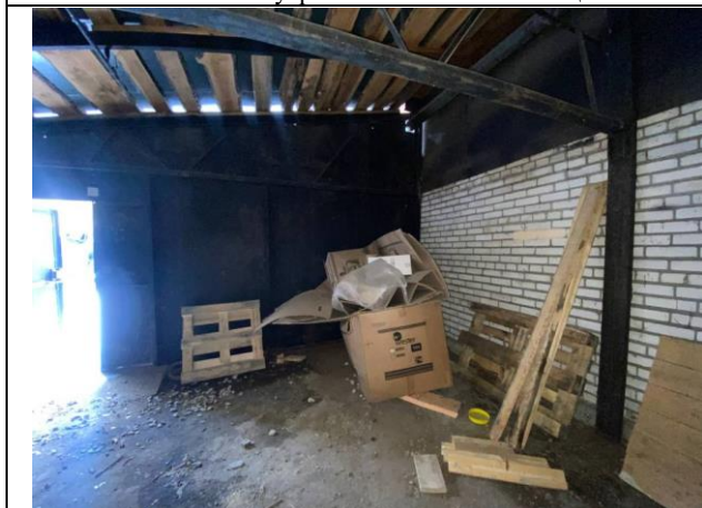
Фото № 7 – Внутреннее состояние помещения
