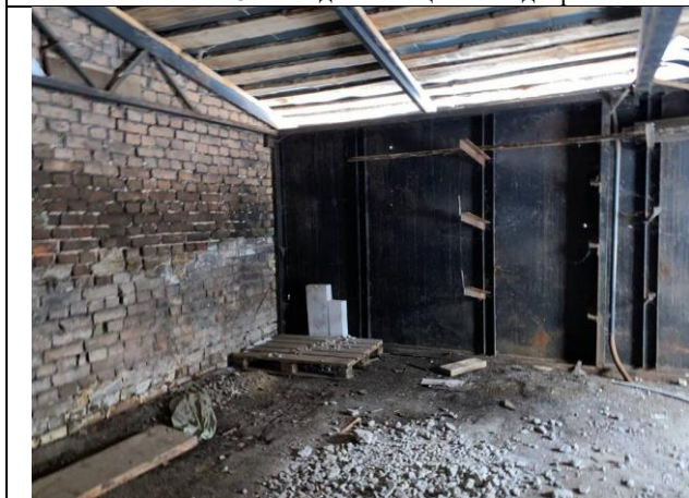
Фото № 5 – Внутреннее состояние помещения
