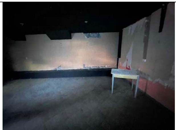
Фото 22. Типичное состояние Объекта оценки
