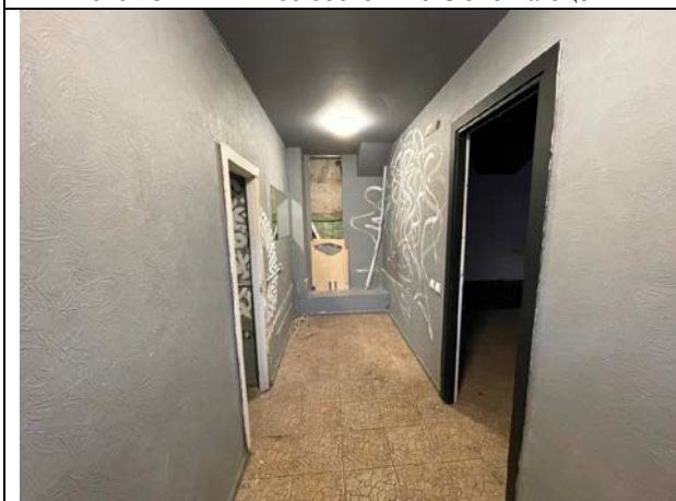
Фото 25. Типичное состояние Объекта оценки
