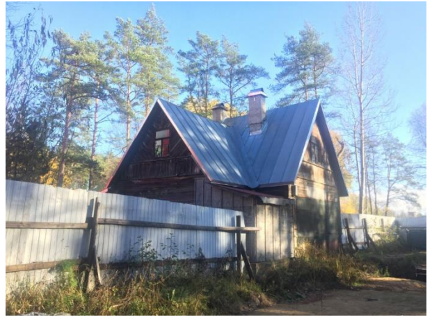
Фото 7.2. Вид на здание размещения Объекта оценки.
