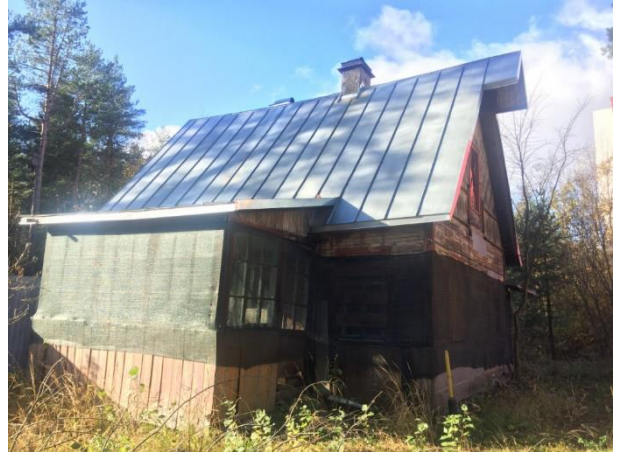
Фото 7.4. Вид на здание размещения Объекта оценки.
