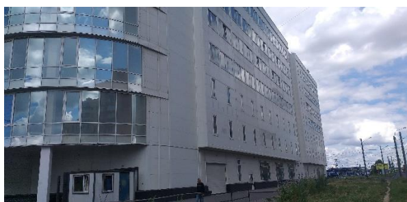
Фото 3. Состояние здания, в котором находится объект оценки
