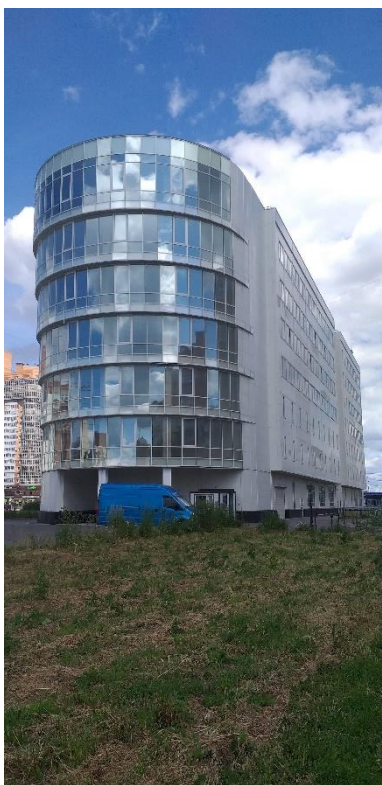
Фото 1. Состояние здания, в котором находится объект оценки
