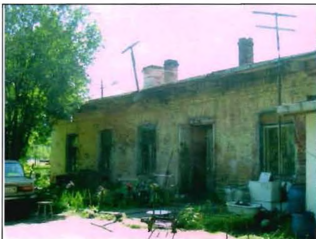
Фото 1. Северный фасад. Фрагмент.
