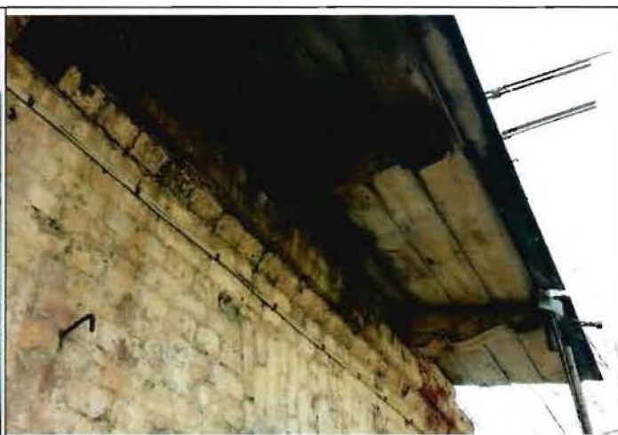
Фото 2. «Кобылки» северного фасада. Общий вид.
