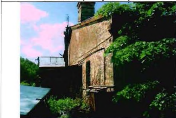
Фото 5. Восточный фасад. Общий вид.
