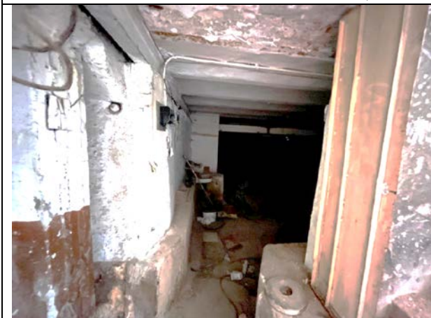
Фото 70. Типичное состояние Объекта оценки
