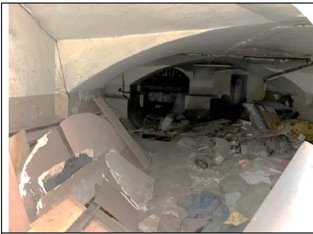
Фото 45. Типичное состояние Объекта оценки
