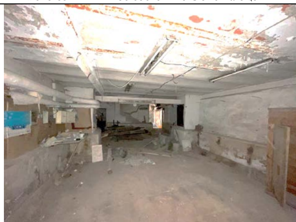
Фото 67. Типичное состояние Объекта оценки
