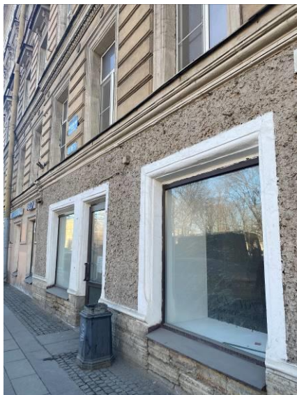
Фото 3. Состояние здания, в котором находится объект оценки
