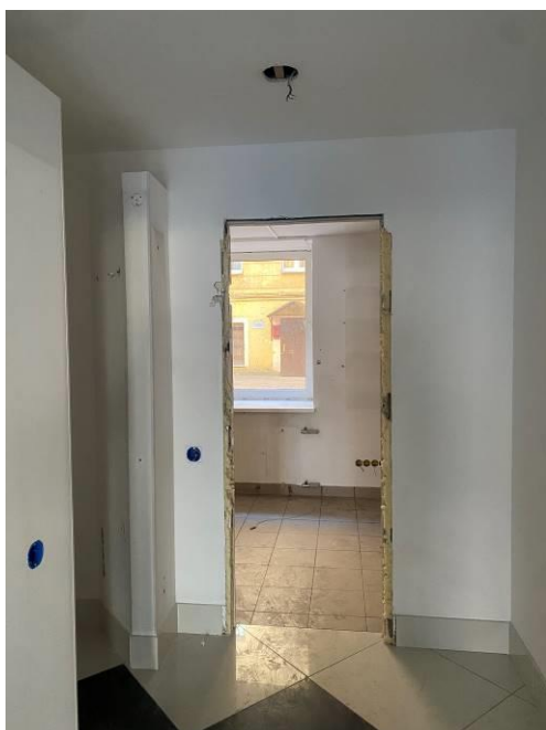
Фото 9. Вид и состояние объекта оценки
