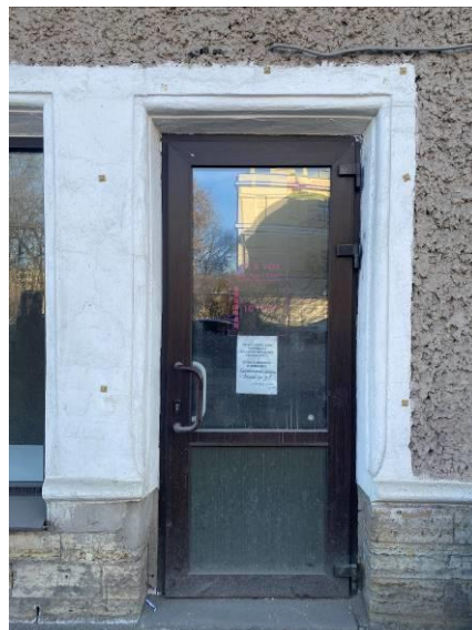
Фото 4. Вход в помещение
