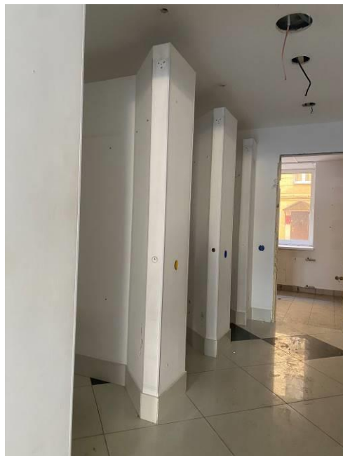
Фото 14. Вид и состояние объекта оценки
