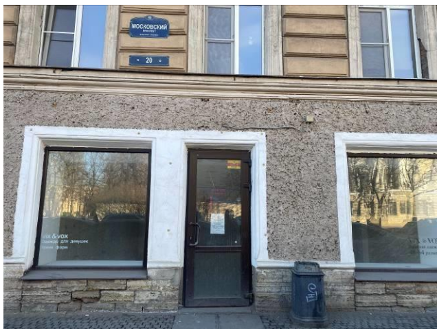
Фото 1. Состояние здания, в котором находится объект оценки
