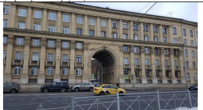
Фото 12. Вид здания расположения Объекта оценки
