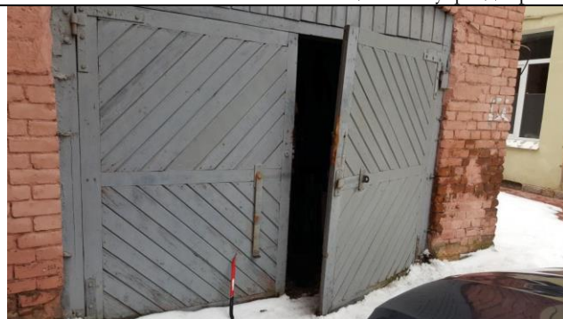
Фото 19. Вход в Объект оценки
