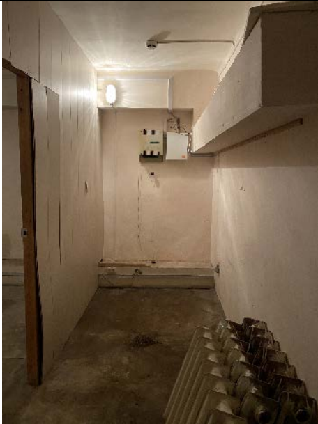
Фото № 21 – Внутреннее состояние помещения 4-Н
