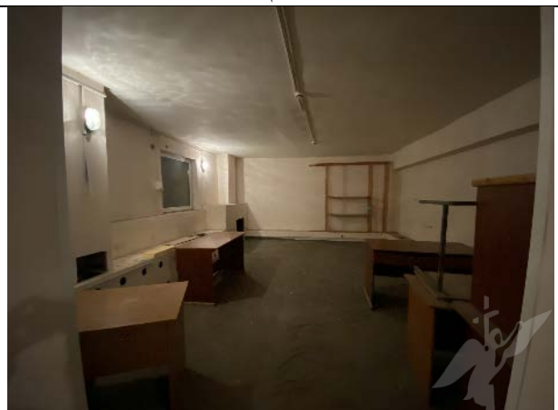
Фото № 24 – Внутреннее состояние помещения 4-Н
