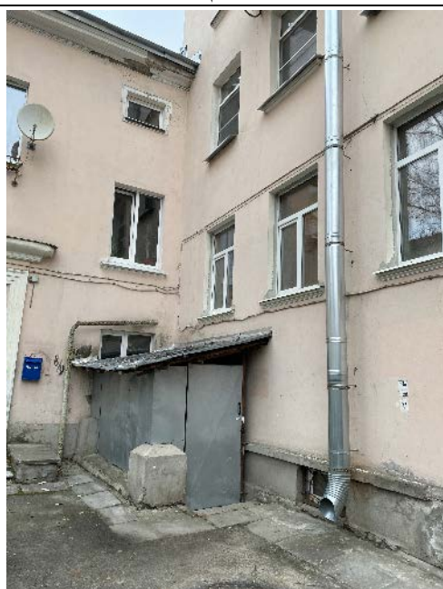
Фото № 3 – Отдельный вход в помещение через приямок
