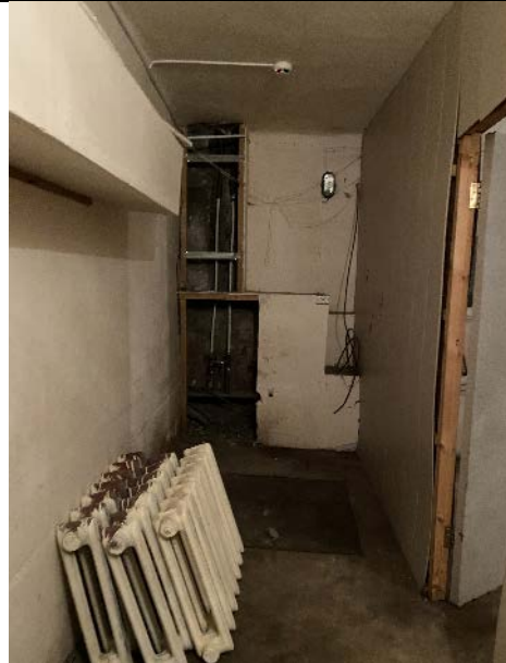
Фото № 22 – Внутреннее состояние помещения 4-Н
