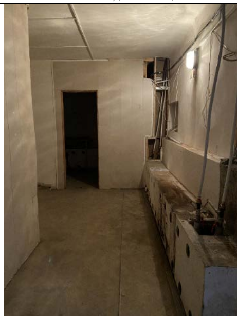
Фото № 10 – Внутреннее состояние помещения 4-Н
