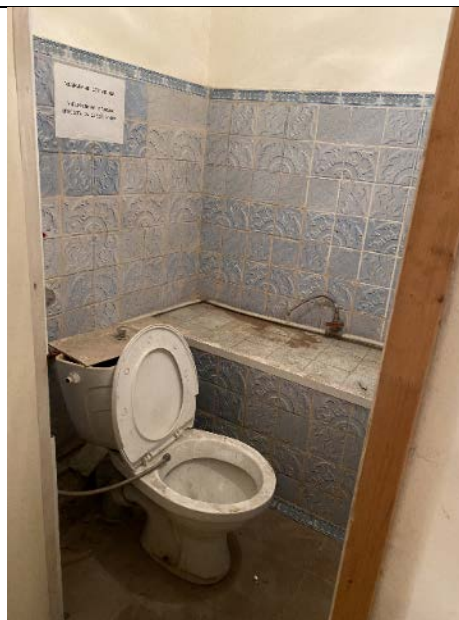
Фото № 14 – Внутреннее состояние помещения 4-Н
