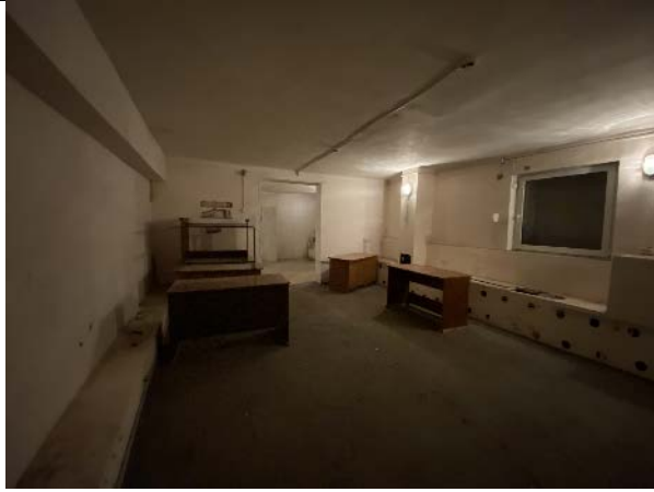
Фото № 25 – Внутреннее состояние помещения 4-Н
