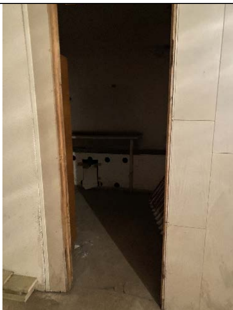
Фото № 11 – Внутреннее состояние помещения 4-Н
