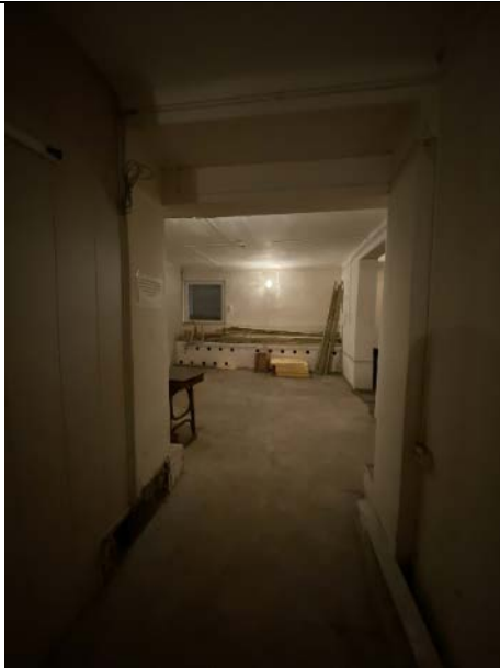
Фото № 19 – Внутреннее состояние помещения 4-Н
