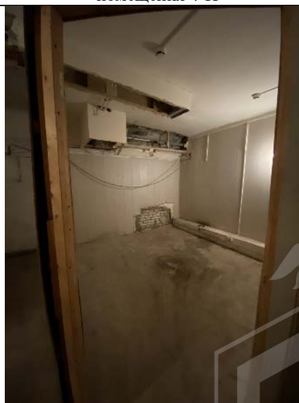
Фото № 18 – Внутреннее состояние помещения 4-Н
