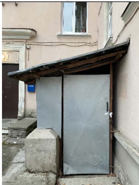
Фото № 4 – Отдельный вход в помещение через приямок
