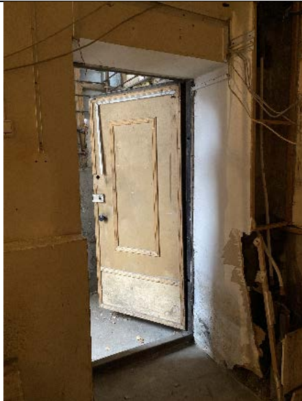
Фото № 8 – Вход в помещение 4-Н
