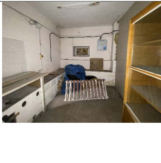
Фото № 16 – Внутреннее состояние помещения 4-Н
