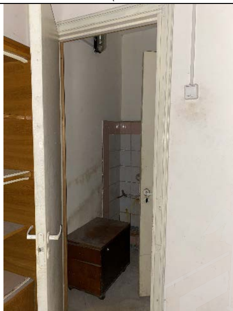
Фото № 12 – Внутреннее состояние помещения 4-Н
