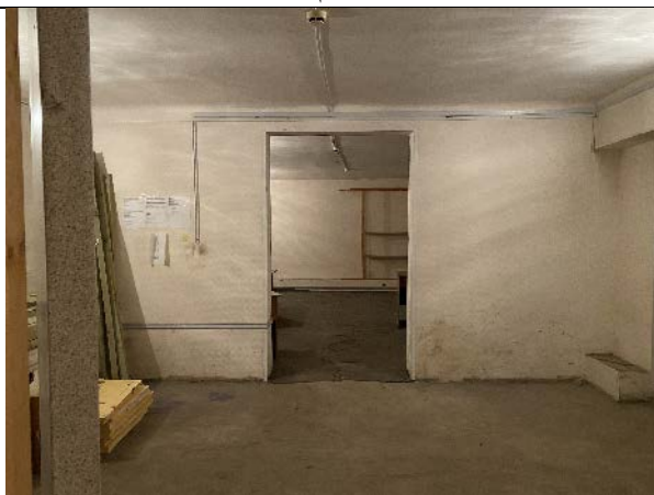
Фото № 23 – Внутреннее состояние помещения 4-Н
