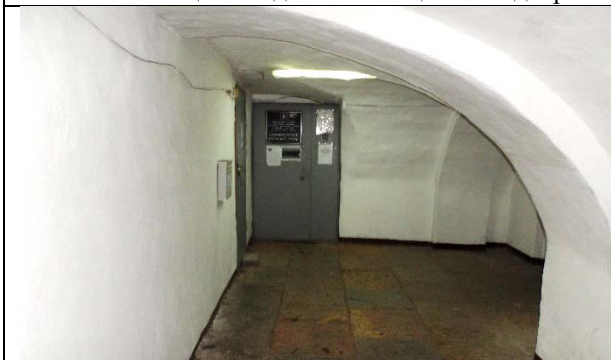
Фото 7. Доступ Объекта оценки (1 этаж)
