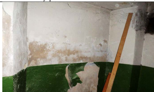
Фото 15. Внутреннее состояние Объекта оценки
