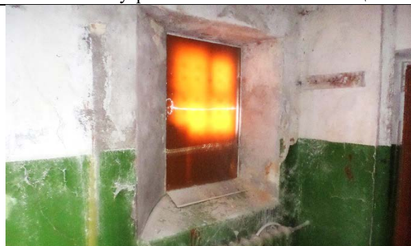
Фото 14. Внутреннее состояние Объекта оценки
