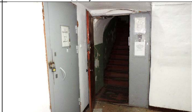
Фото 8. Доступ Объекта оценки (1 этаж)
