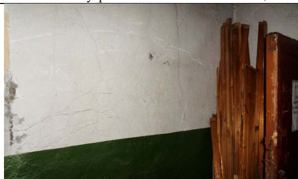
Фото 16. Внутреннее состояние Объекта оценки
