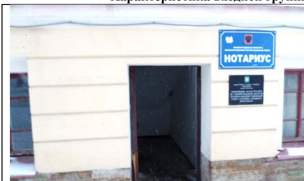
Фото 5. Общий вход Объекта оценки со двора
