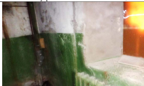
Фото 13. Внутреннее состояние Объекта оценки
