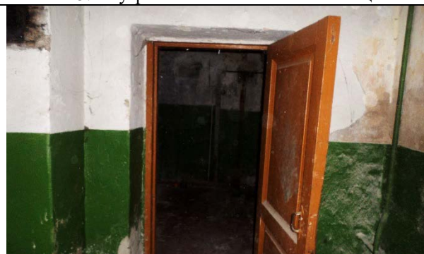
Фото 17. Внутреннее состояние Объекта оценки
