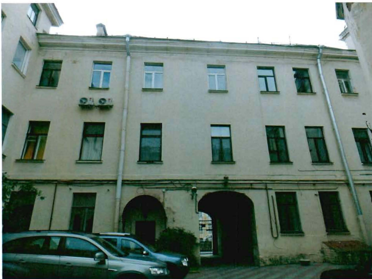
5. Дворовый фасад корпуса по набережной реки Мойки.
