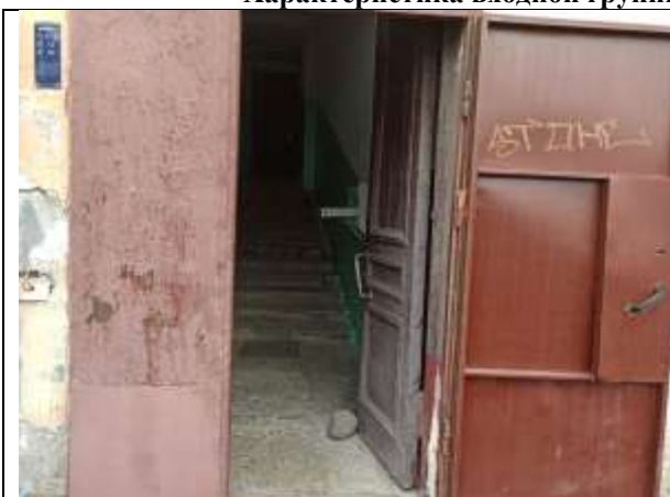
Фото 7. Общий вход с улицы
