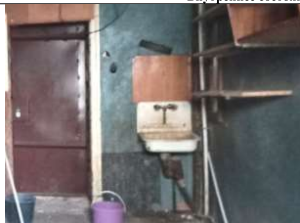
Фото 11. Внутреннее состояние Объекта оценки
