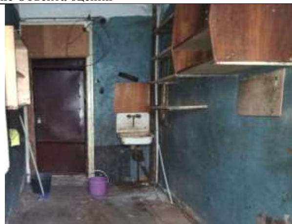
Фото 12. Внутреннее состояние Объекта оценки
