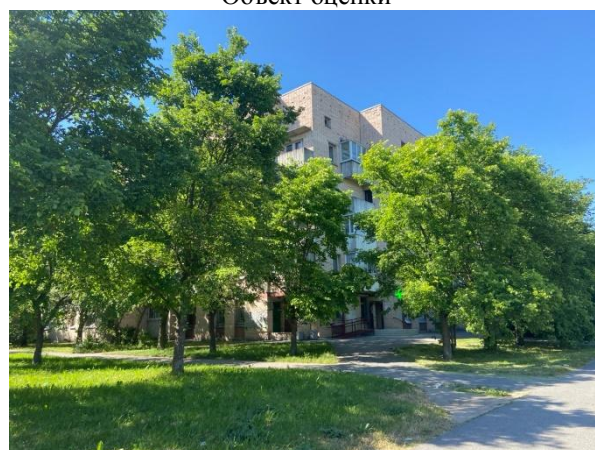
Фото 10. Вид здания, в котором расположен Объект оценки
