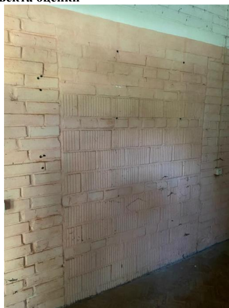
Фото 15. Выход на лестничную клетку – заложен
