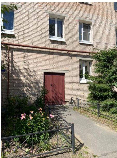
Фото 13. Общий вход со двора Внутреннее состояние Объекта оценки
