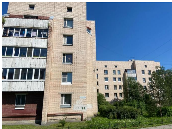
Фото 7. Вид здания, в котором расположен Объект оценки
