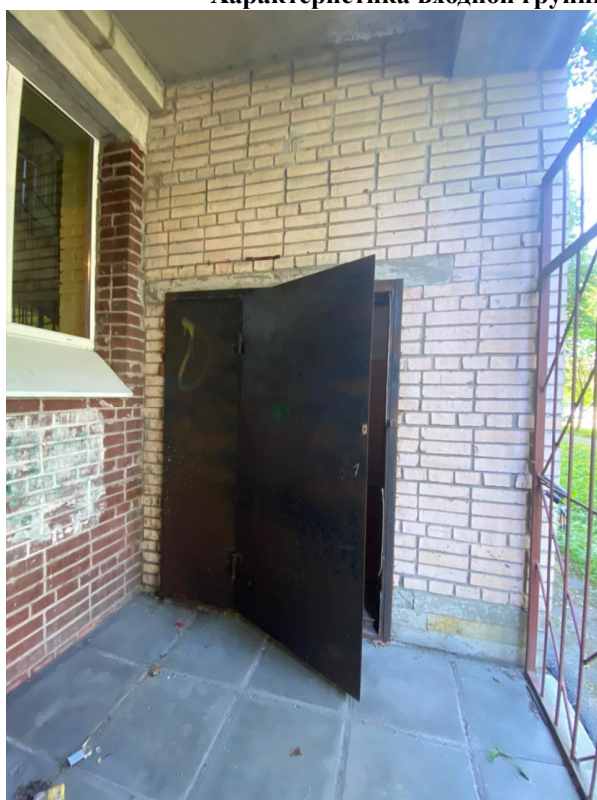
Фото 11. Отдельный вход с улицы
