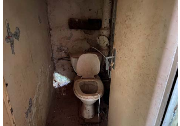
Фото № 8 - Внутренне состояние
