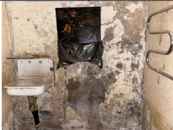
Фото № 9 - Внутренне состояние
