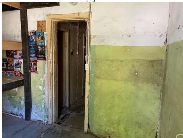
Фото № 11 - Внутренне состояние
