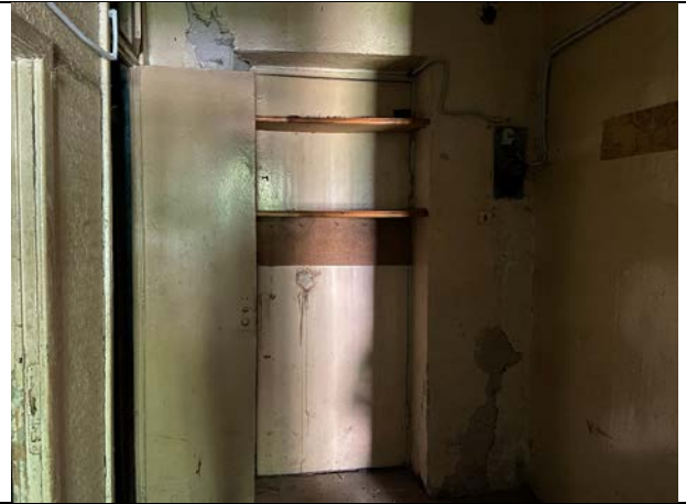
Фото № 6 - Внутренне состояние
