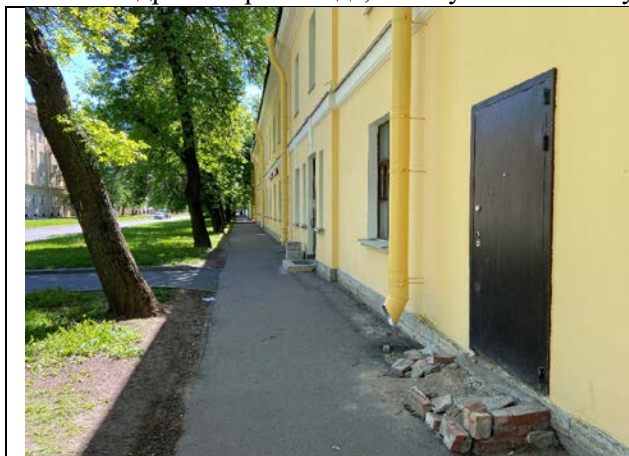
Фото № 1 – Вход в помещение
