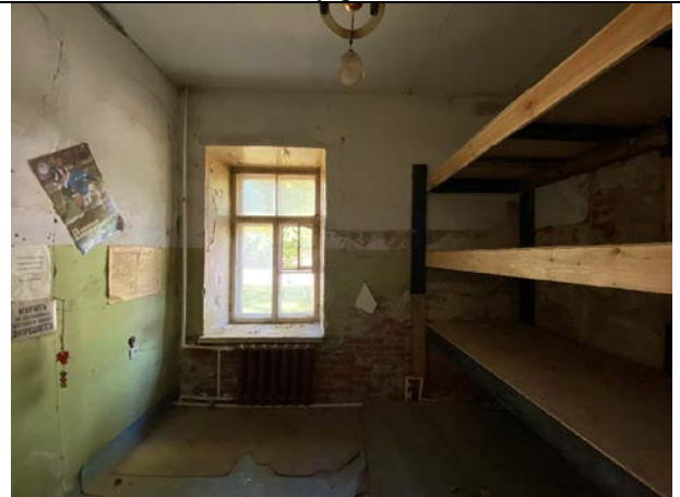
Фото № 10 - Внутренне состояние
