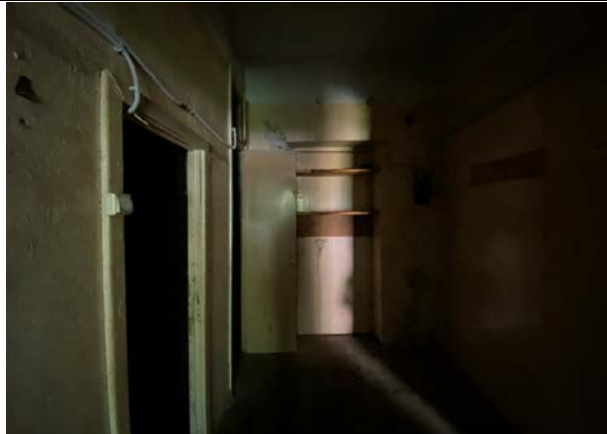
Фото № 7 - Внутренне состояние
