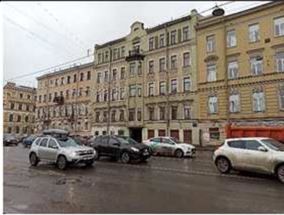
Фото № 25 – Фасад здания
