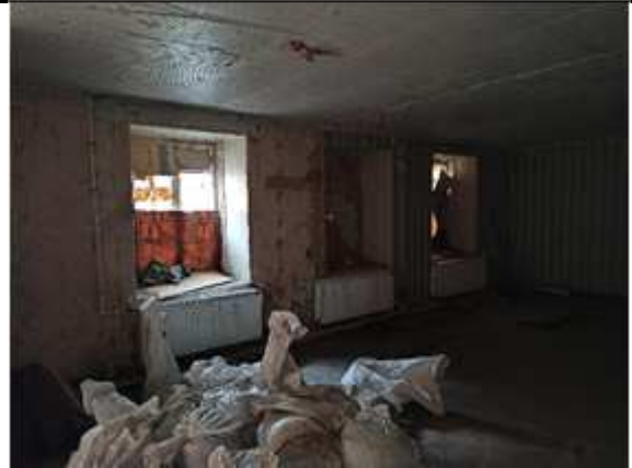
Фото № 10 - Внутренне состояние
