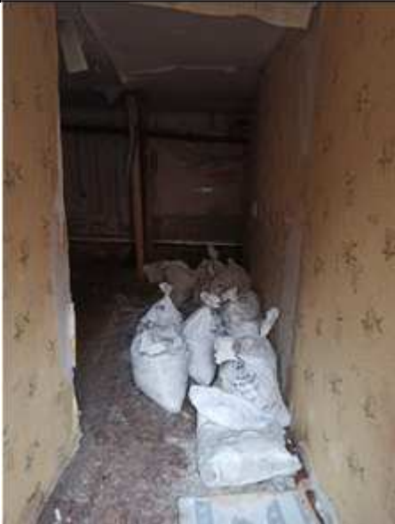
Фото № 7 – Внутренне состояние
