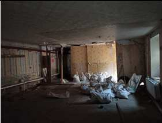
Фото № 11 - Внутренне состояние
