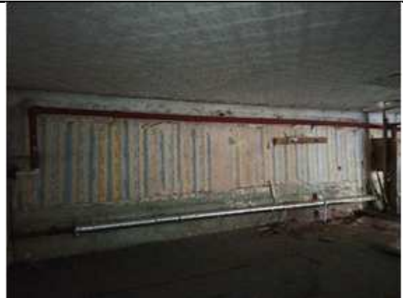
Фото № 12 - Внутренне состояние
