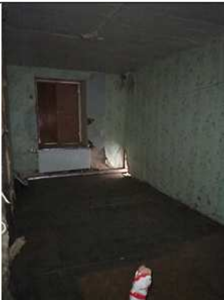
Фото № 15 - Внутренне состояние
