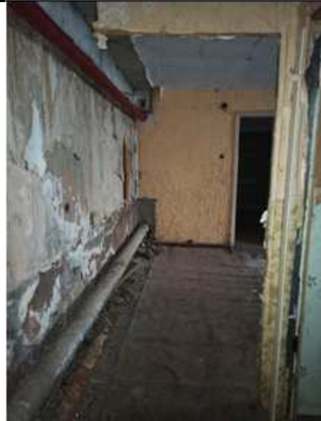
Фото № 14 - Внутренне состояние
