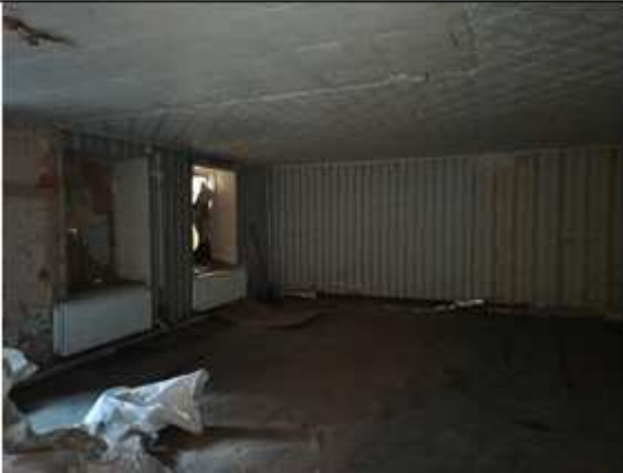
Фото № 9 - Внутренне состояние
