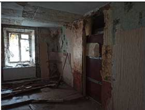
Фото № 17 - Внутренне состояние
