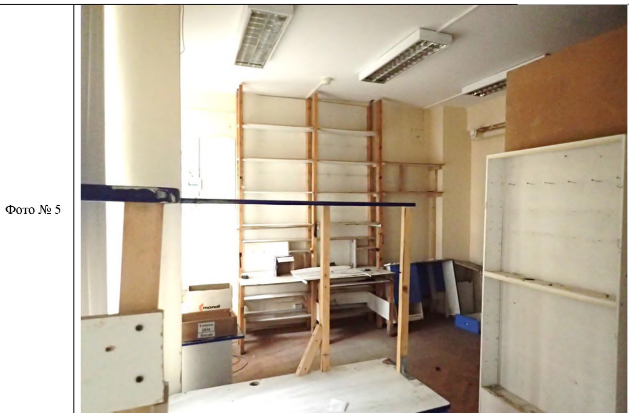
Описание: Вид внутри Объекта, находится бытовой мусор
