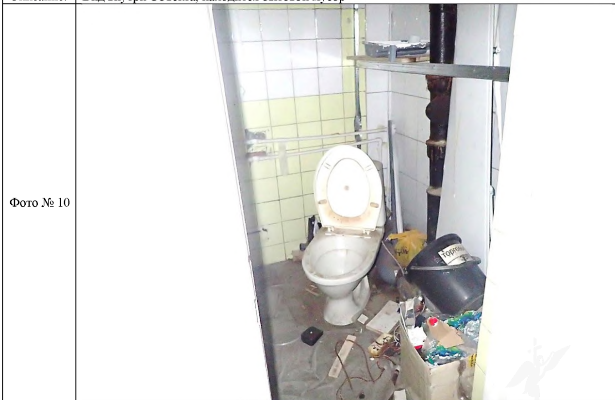
Описание: Вид внутри Объекта, находится бытовой мусор
