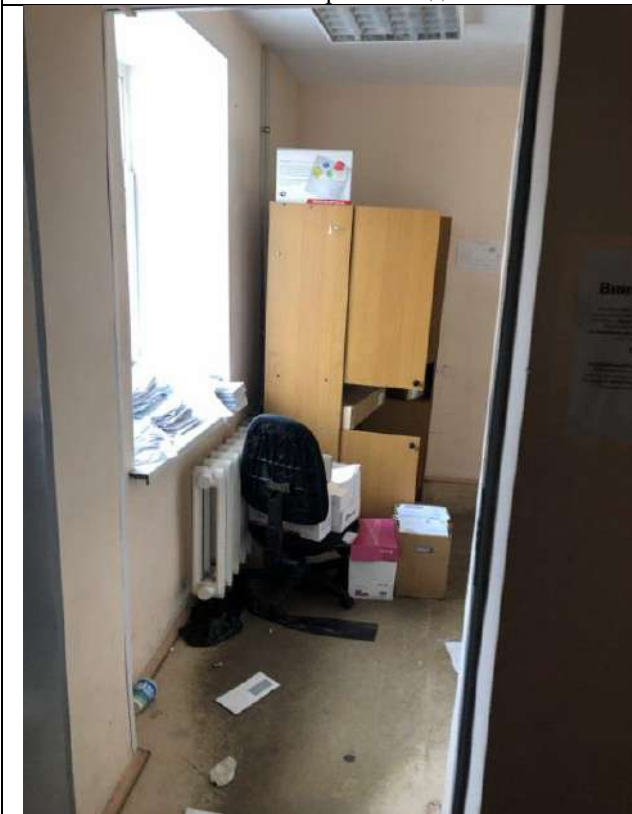
Фото 59. Состояние внутренней отделки пом. 3-Н (третий этаж)
