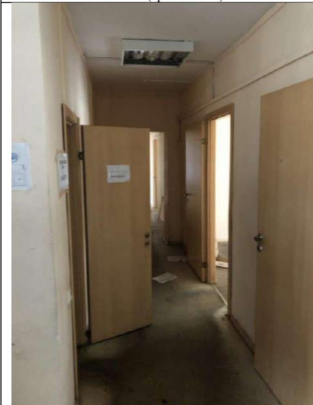
Фото 63. Состояние внутренней отделки пом. 3-Н (третий этаж)
