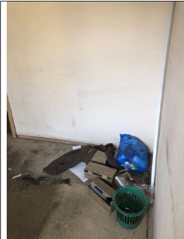
Фото 61. Состояние внутренней отделки пом. 3-Н (третий этаж)
