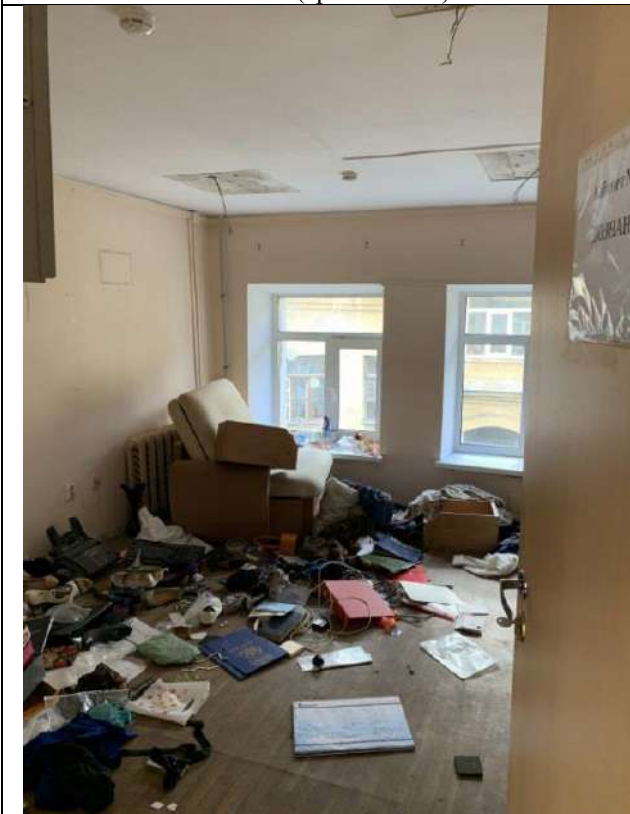
Фото 75. Состояние внутренней отделки пом. 3-Н (третий этаж)
