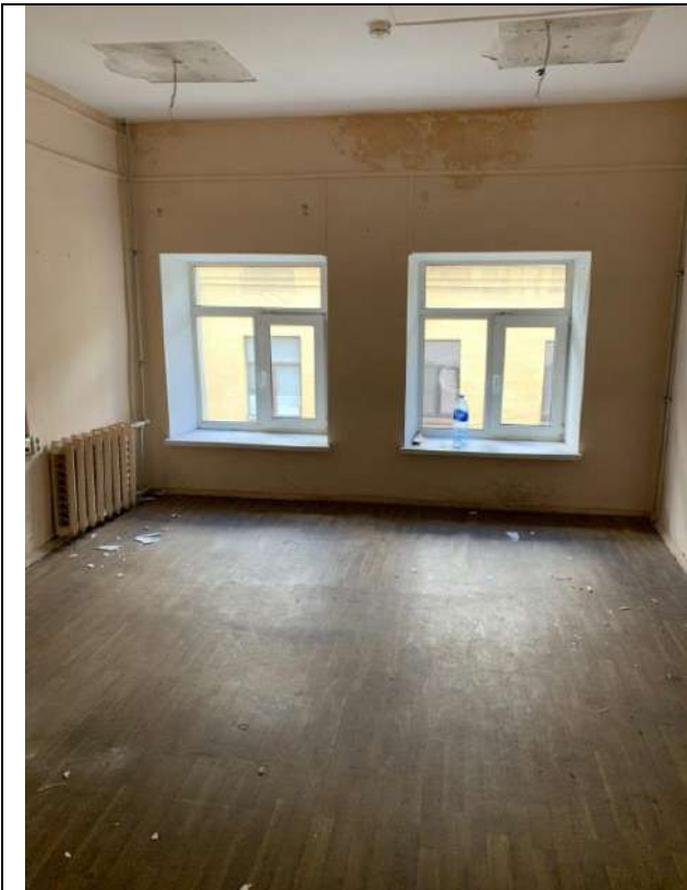
Фото 65. Состояние внутренней отделки пом. 3-Н (третий этаж)
