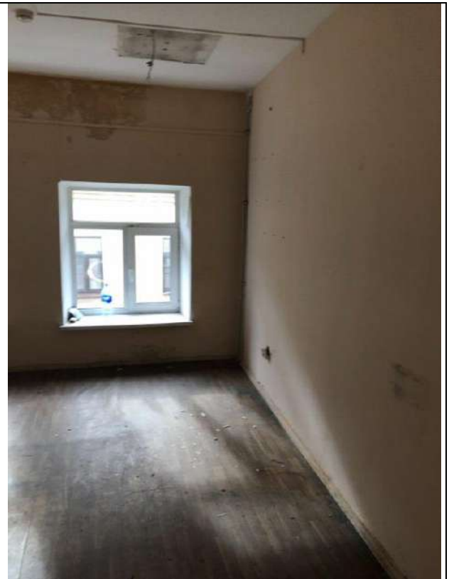
Фото 70. Состояние внутренней отделки пом. 3-Н (третий этаж)
