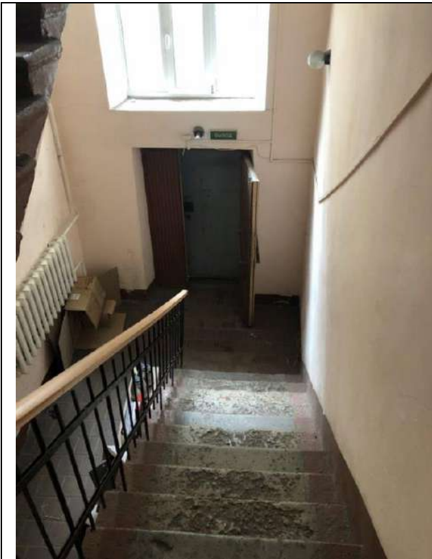
Фото 9. Подъем на 1 этаж
