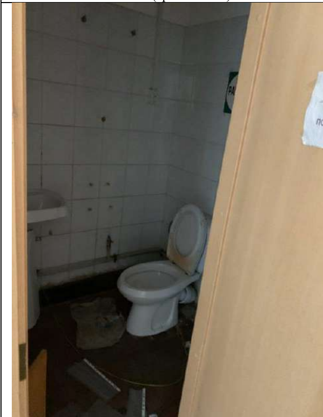
Фото 67. Состояние внутренней отделки пом. 3-Н (третий этаж)
