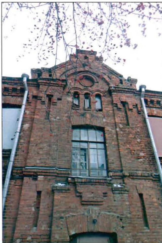
3. Южный фасад. Фрагмент.
