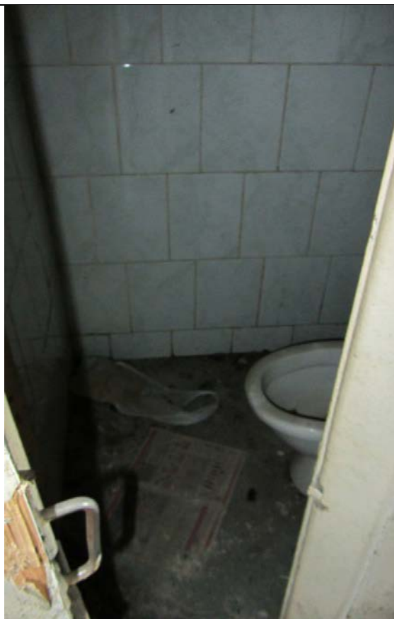
Фото 98. Состояние ч.п.2 пом. 2С-Н
