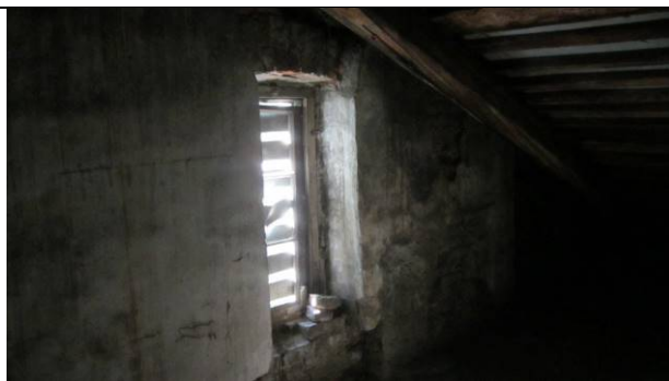
Фото 140. Состояние пом. 1 н.ч.
