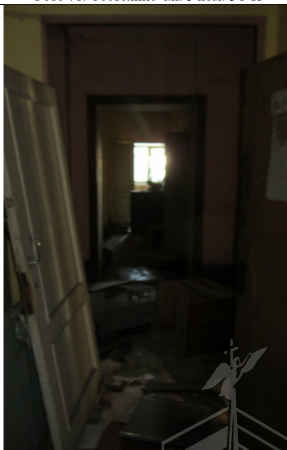
Фото 80. Состояние ч.п. 1 пом. 3С-Н
