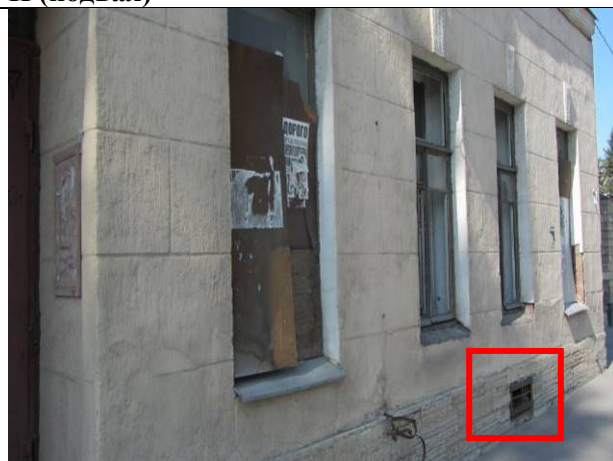
Фото 162. Окно пом. 2-Н, выходящее на улицу
