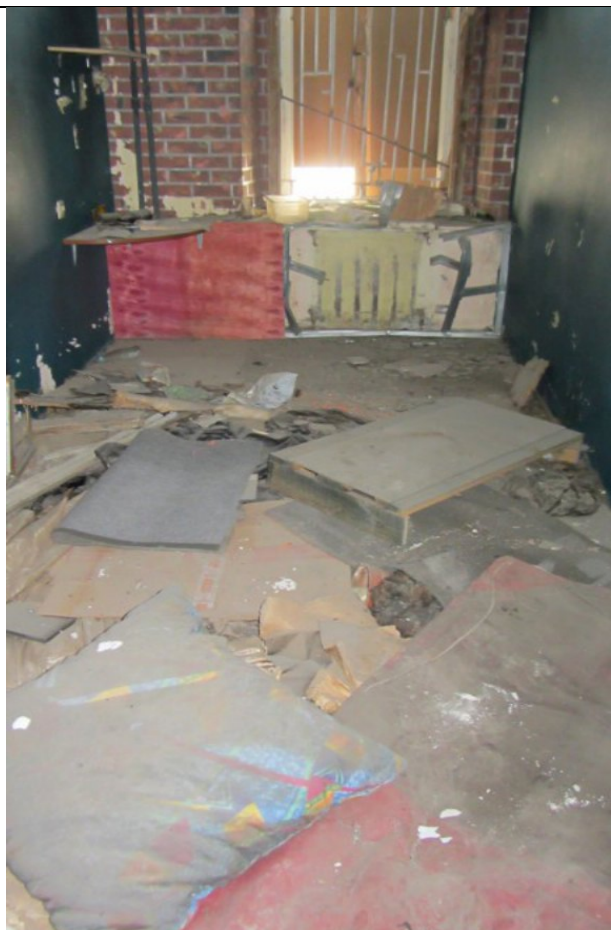
Фото 94. Состояние ч.п.6 пом. 2С-Н
