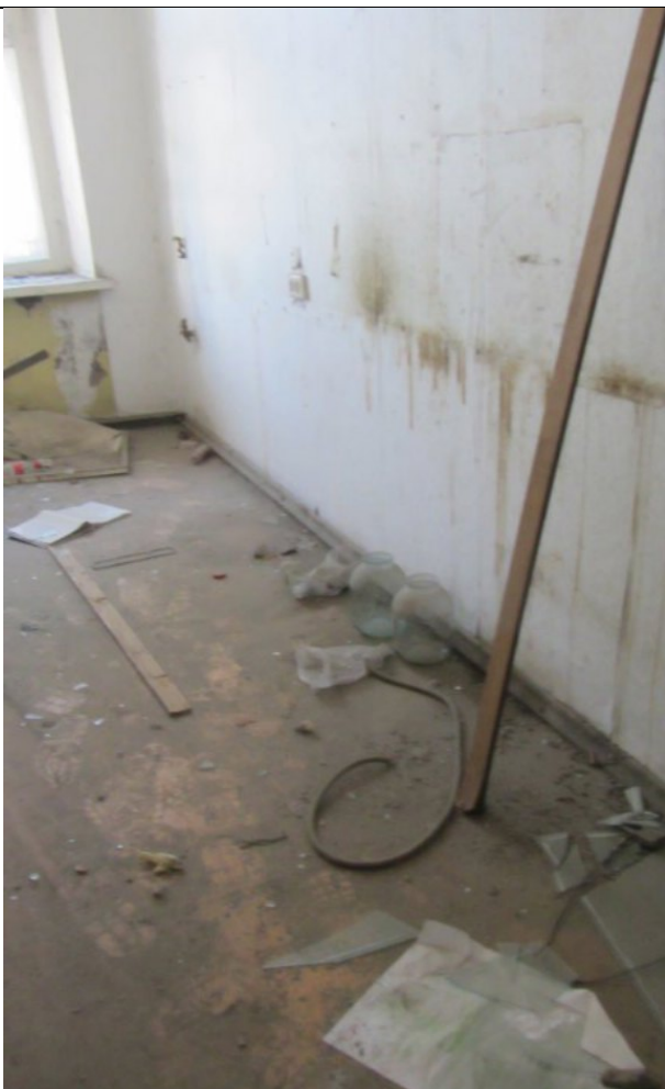
Фото 75. Состояние ч.п. 11 пом. 3С-Н
