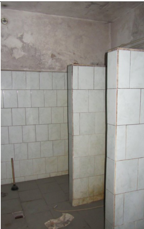
Фото 63. Состояние ч.п. 4 пом. 3С-Н
