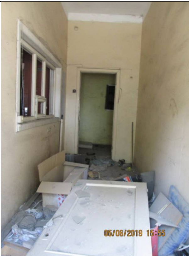
Фото 59. Состояние ч.п. 13 пом. 3С-Н
