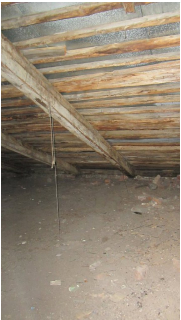
Фото 143. Состояние пом. 1 н.ч.
