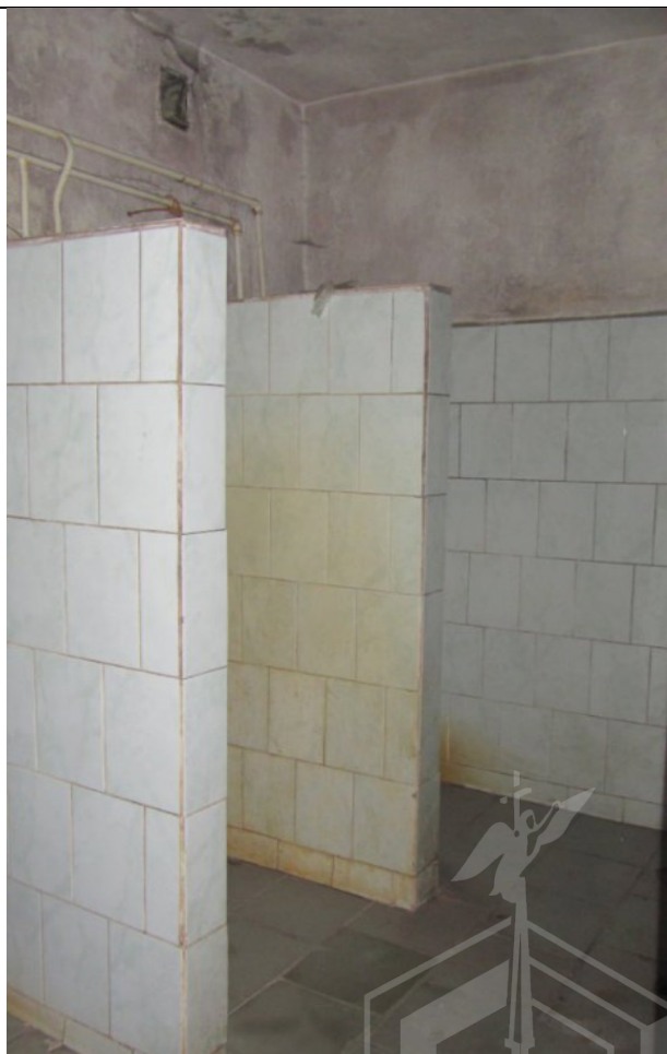
Фото 64. Состояние ч.п. 4 пом. 3С-Н
