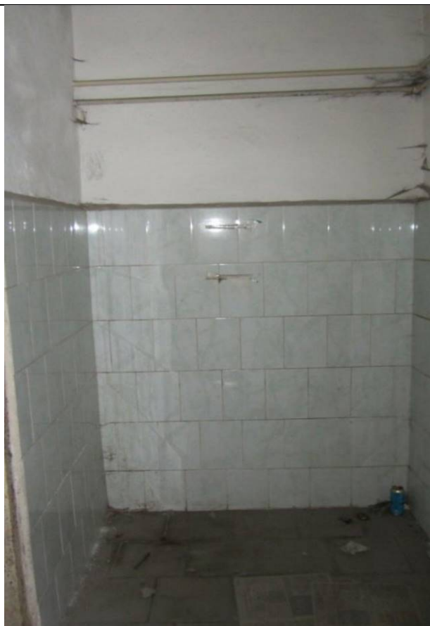
Фото 62. Состояние ч.п. 4 пом. 3С-Н
