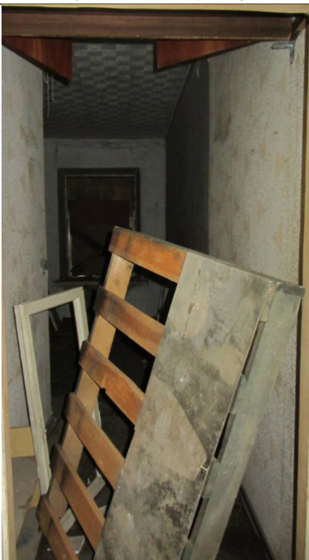
Фото 83. Состояние ч.п. 8 пом. 3С-Н
