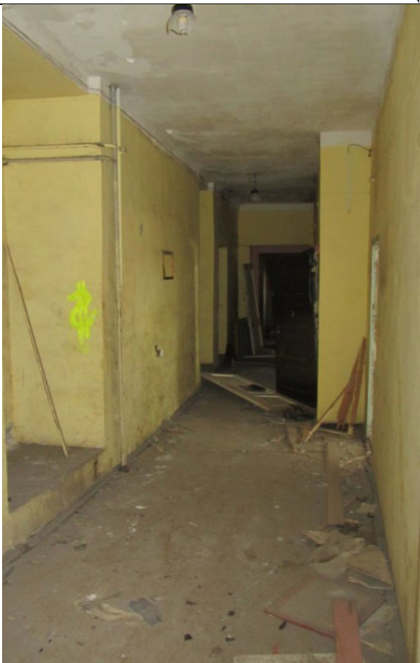
Фото 57. Состояние ч.п.1 пом. 3С-Н
