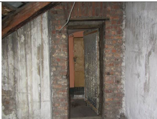
Фото 146. Состояние пом. 1 н.ч. (выход на лестницу №1)
