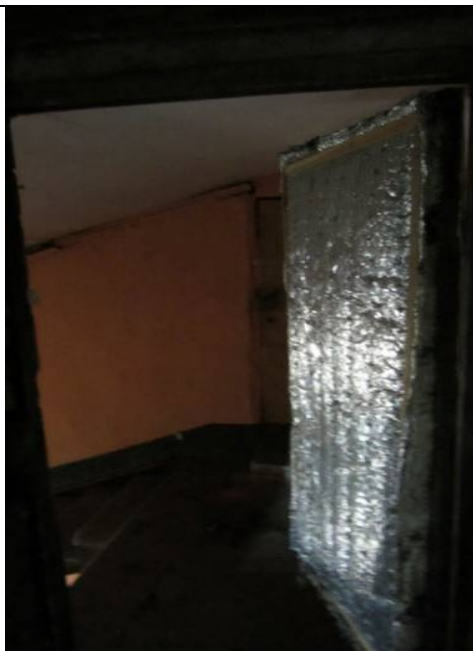
Фото 147. Выход на лестницу №1 из пом. 1 н.ч.
