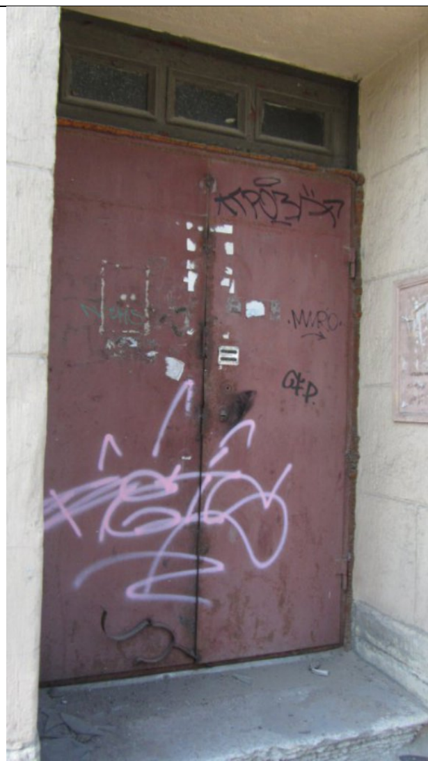
Фото 28. Вход на лестничную клетку №2
