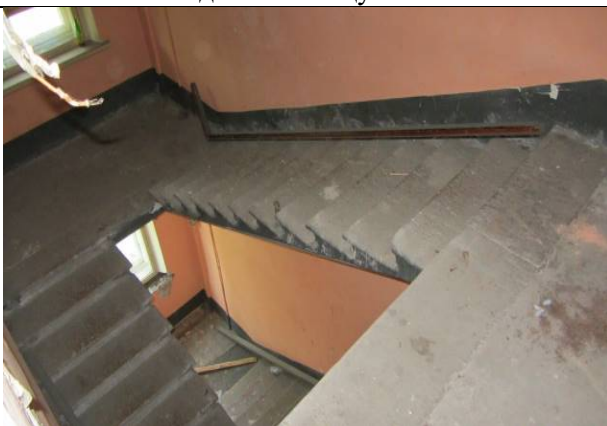
Фото 149. Подход к пом. 1 н.ч. с лестницы №1
