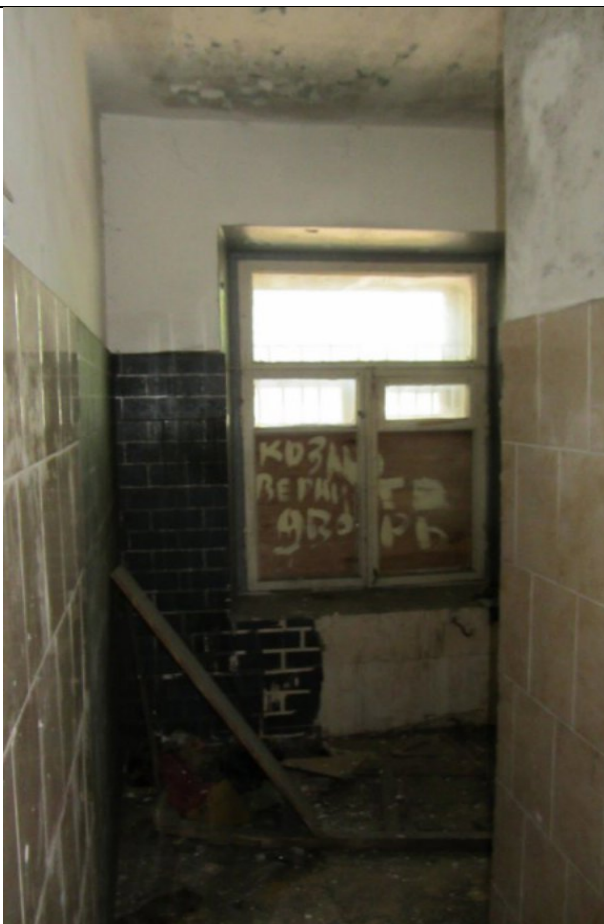
Фото 65. Состояние ч.п. 2 пом. 3С-Н
