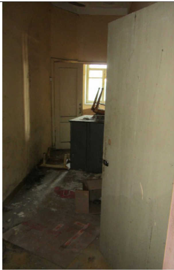
Фото 90. Вход в пом. 2С-Н (состояние ч.п.1)
