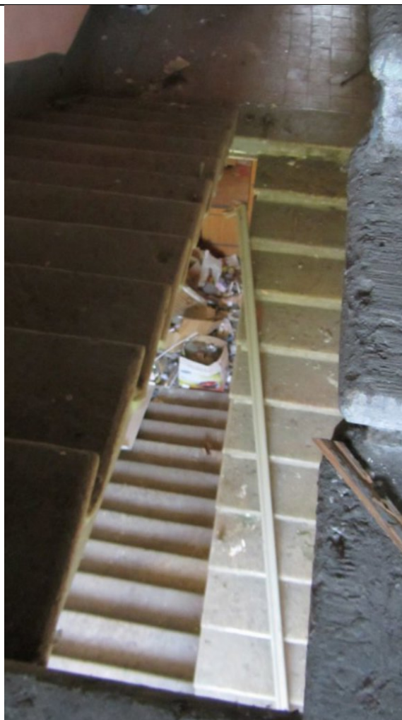
Фото 118. Подход к пом. 1 н.ч. по лестнице №2
