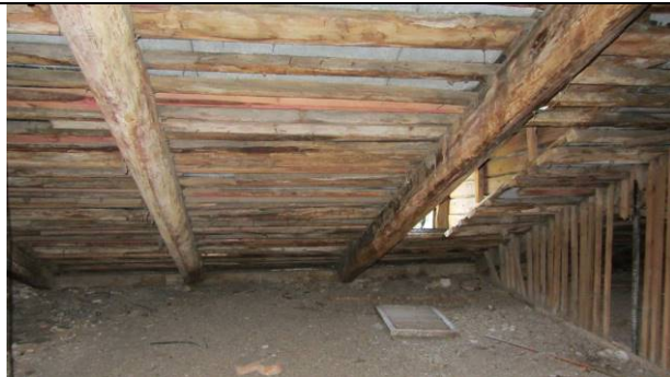
Фото 134. Состояние пом. 1 н.ч.
