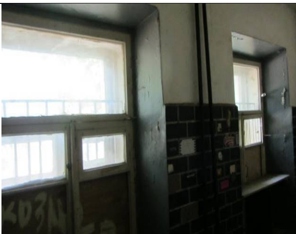
Фото 69. Состояние ч.п. 2 пом. 3С-Н
