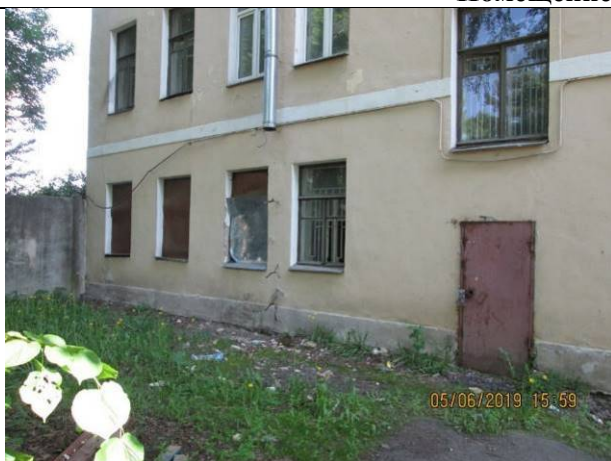
Фото 161. Общий вход в пом. 2-Н со двора
