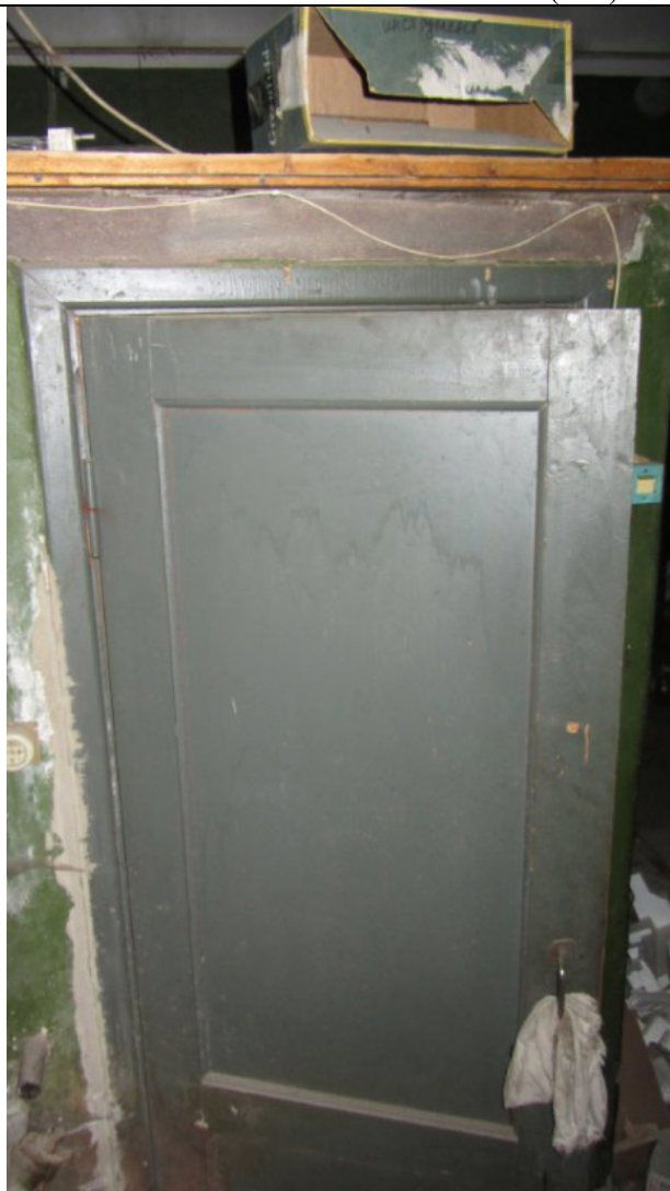
Фото 46. Входная дверь в ч.п. 2 пом. 4С-Н
