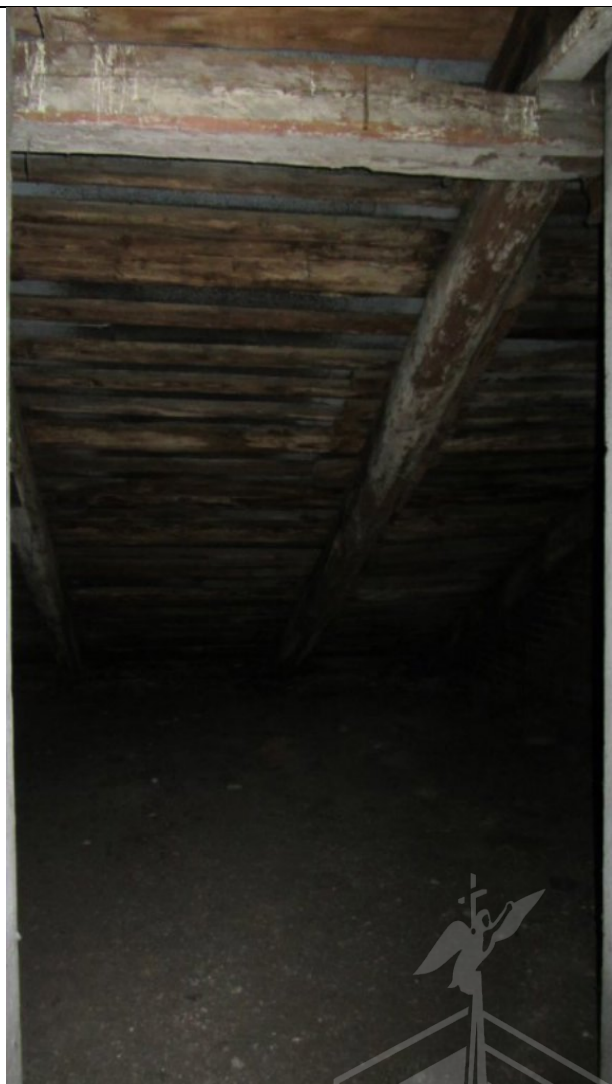
Фото 144. Состояние пом. 1 н.ч.
