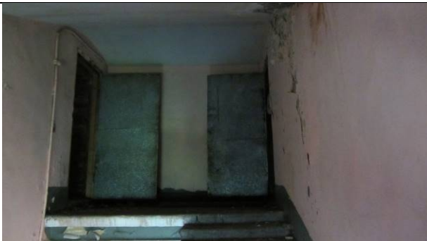
Фото 119. Вход на чердак помещение 1 н.ч. (с лестницы №2)
