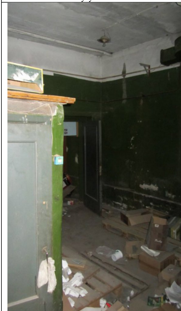
Фото 41. Состояние ч.п.1 пом. 4С-Н
