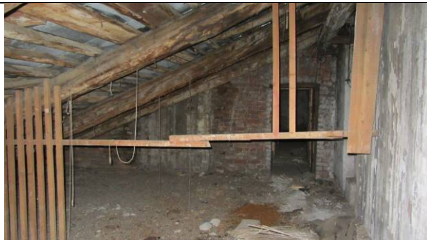
Фото 136. Состояние пом. 1 н.ч.
