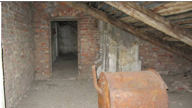
Фото 124. Состояние пом. 1 н.ч.
