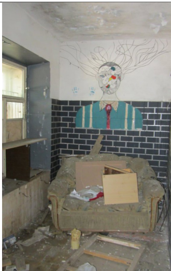
Фото 67. Состояние ч.п. 2 пом. 3С-Н
