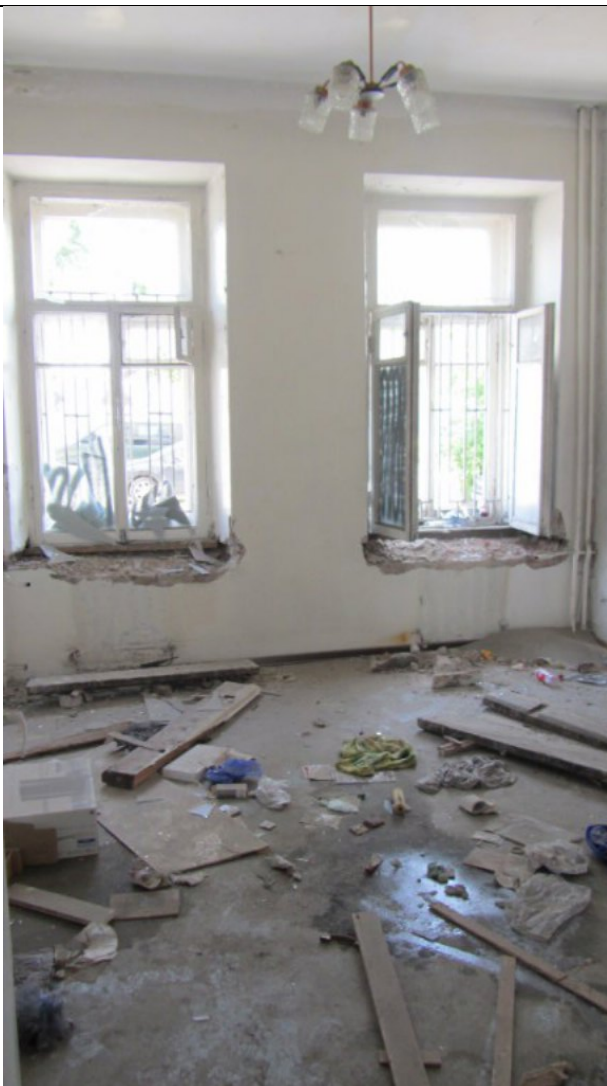
Фото 71. Состояние ч.п. 12 пом. 3С-Н
