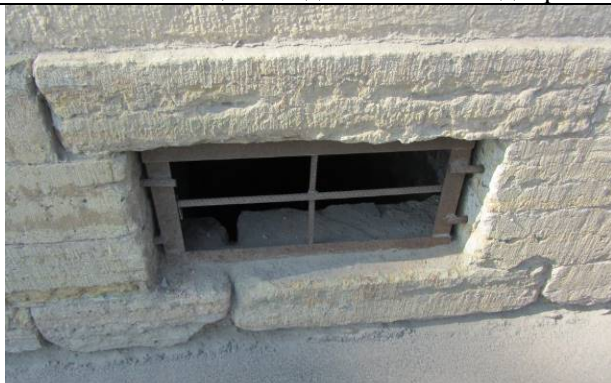
Фото 163. Окно пом. 2-Н, выходящее на улицу
