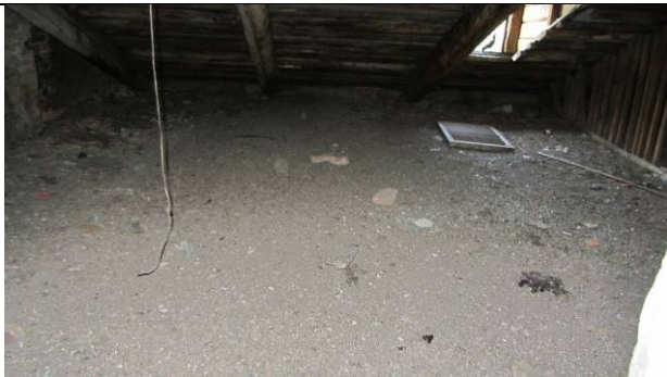
Фото 128. Состояние пом. 1 н.ч.
