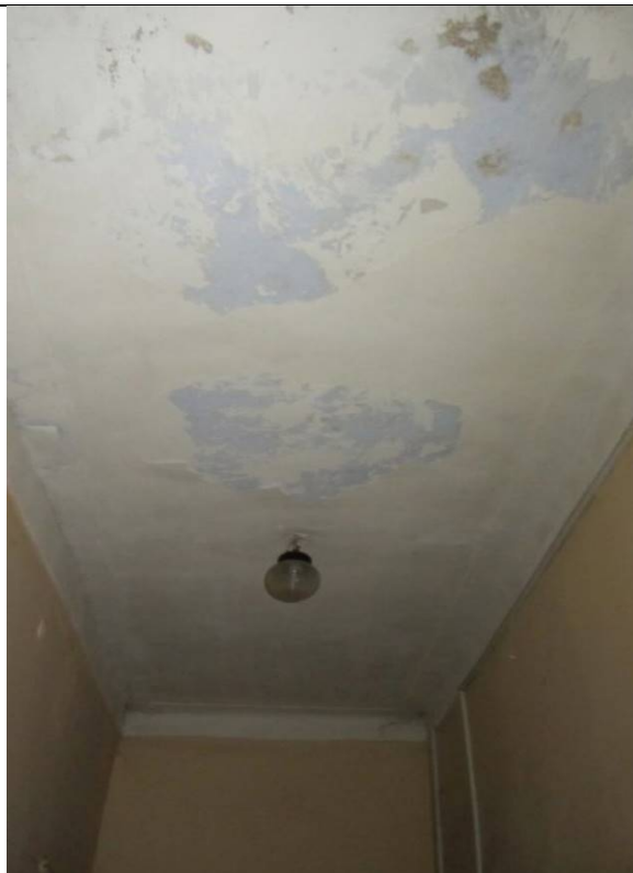
Фото 109. Состояние ч.п.4 пом. 2С-Н
