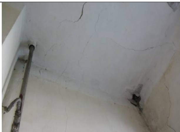
Фото 102. Состояние ч.п.3 пом. 2С-Н
