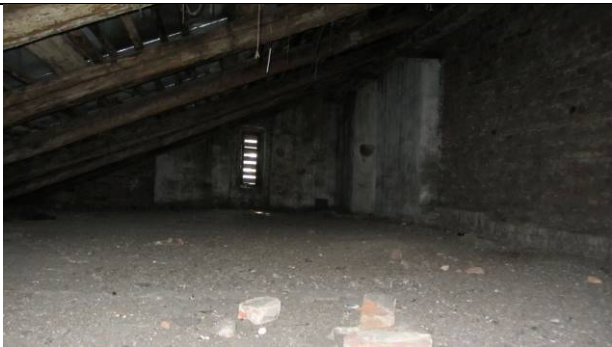
Фото 127. Состояние пом. 1 н.ч.
