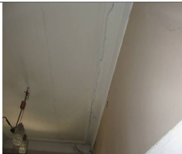
Фото 82. Состояние ч.п. 7 пом. 3С-Н
