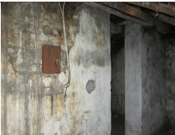
Фото 145. Состояние пом. 1 н.ч.
