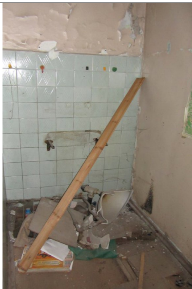
Фото 78. Состояние ч.п. 5 пом. 3С-Н
