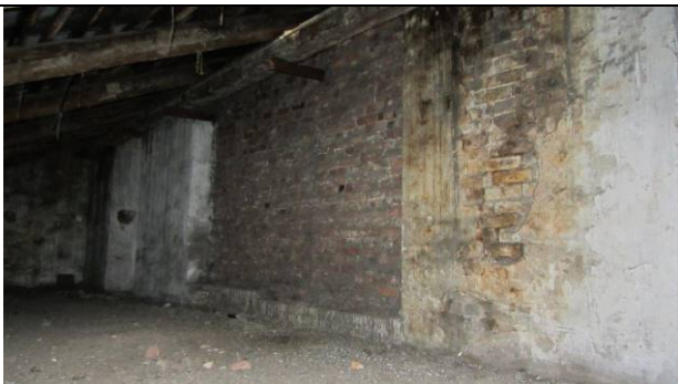
Фото 125. Состояние пом. 1 н.ч.
