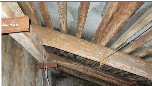
Фото 142. Состояние пом. 1 н.ч.
