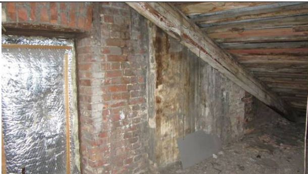
Фото 135. Состояние пом. 1 н.ч.
