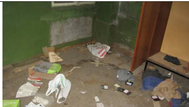
Фото 52. Состояние ч.п.3 пом. 4С-Н
