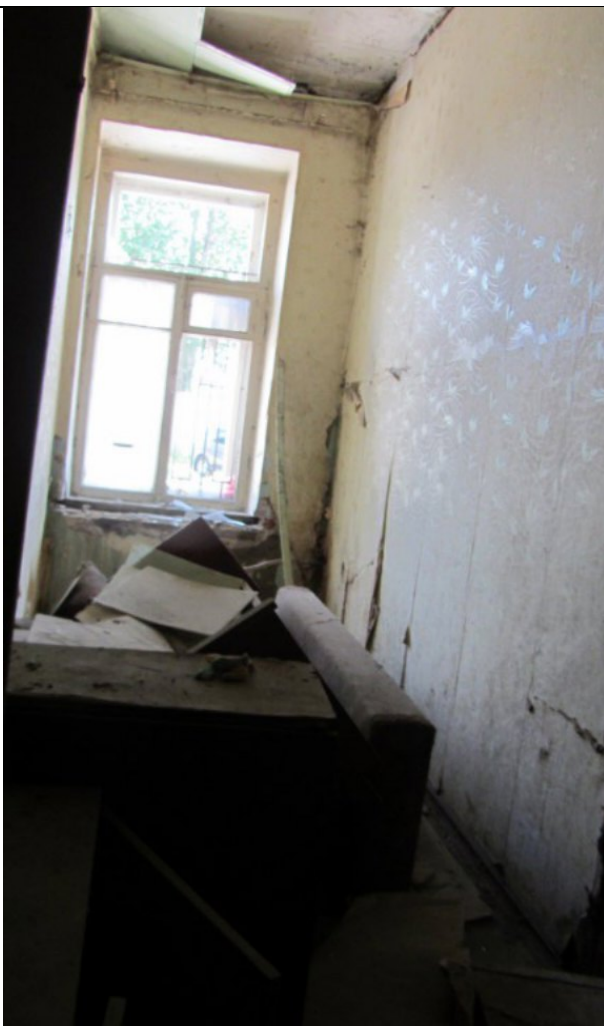
Фото 85. Состояние ч.п. 9 пом. 3С-Н
