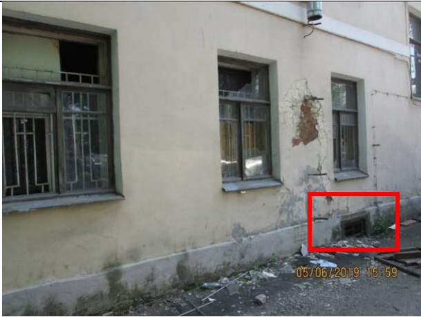
Фото 155. Окно пом. 1-Н, выходящее во двор
