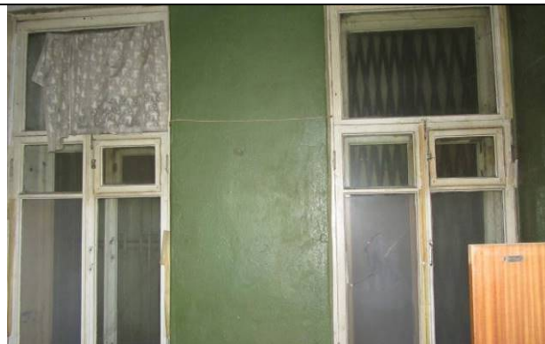
Фото 54. Состояние ч.п.3 пом. 4С-Н
