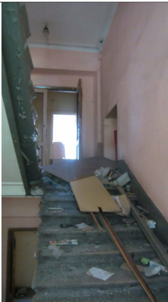
Фото 117. Подход к пом. 1 н.ч. по лестнице №2
