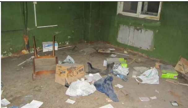
Фото 51. Состояние ч.п.3 пом. 4С-Н
