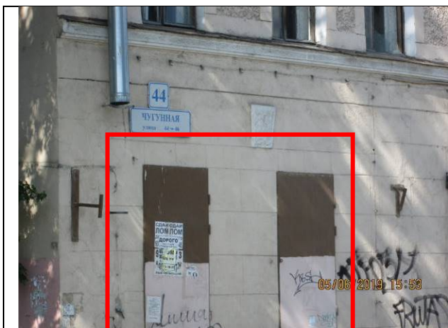
Фото 39. Окна пом. 4С-Н, выходящие на ул. Чугунная
