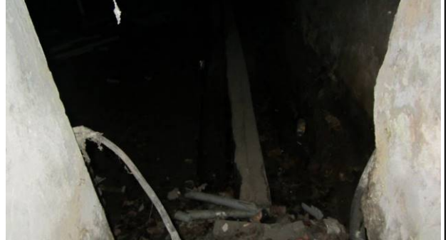
Фото 158. Состояние пом. 1-Н
