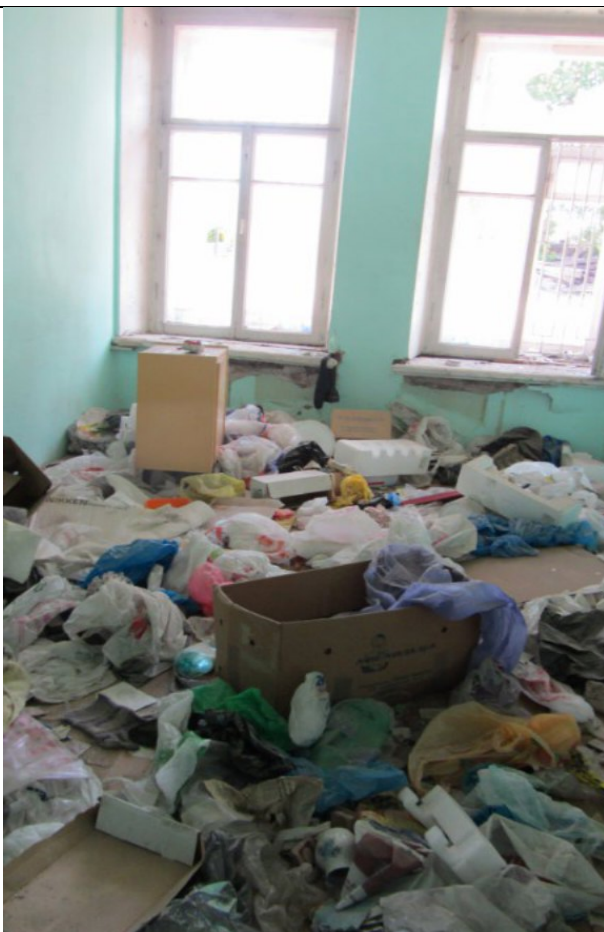
Фото 95. Состояние ч.п.5 пом. 2С-Н
