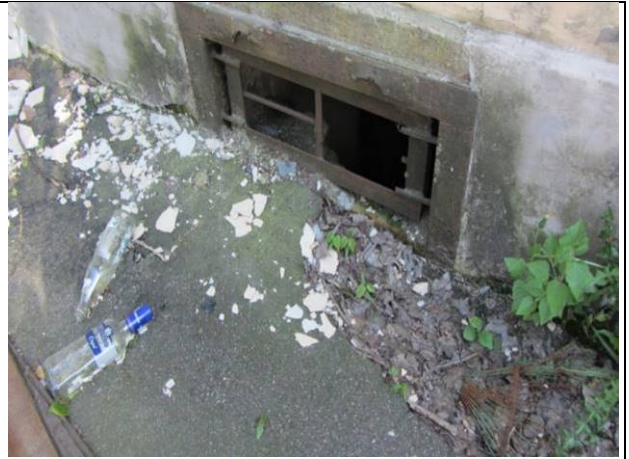
Фото 156. Окно пом. 1-Н, выходящее во двор
