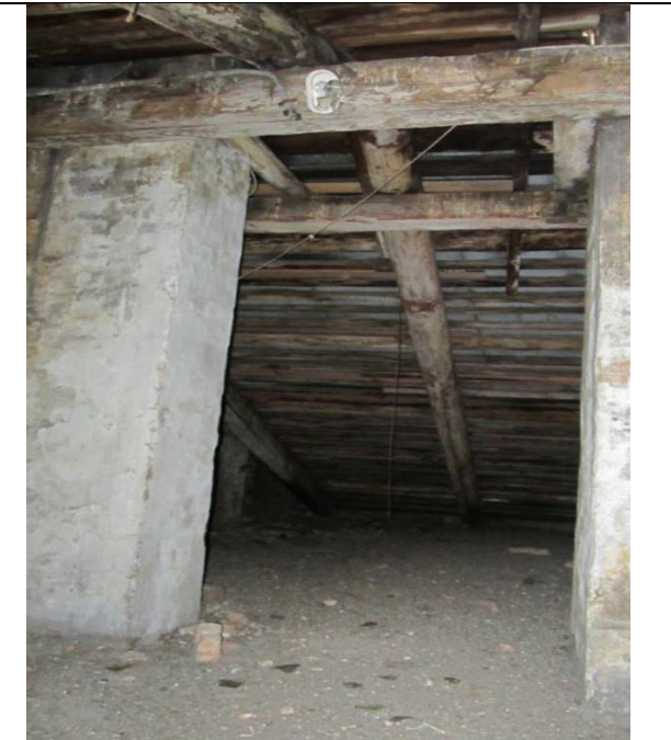
Фото 129. Состояние пом. 1 н.ч.
