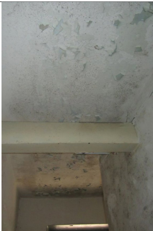
Фото 66. Состояние ч.п. 2 пом. 3С-Н
