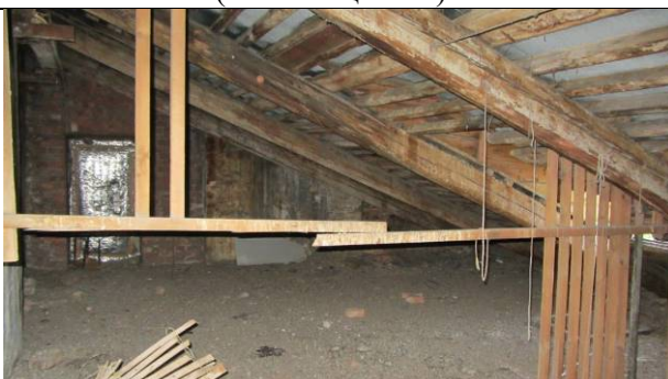
Фото 121. Состояние пом. 1 н.ч.
