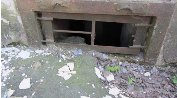
Фото 157. Окно пом. 1-Н, выходящее во двор
