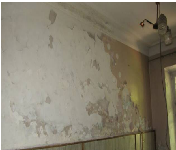
Фото 81. Состояние ч.п. 7 пом. 3С-Н
