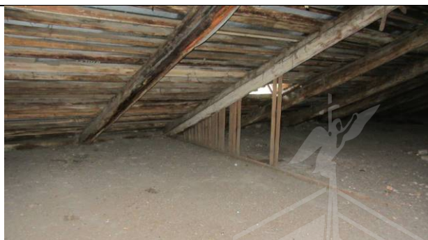
Фото 122. Состояние пом. 1 н.ч.
