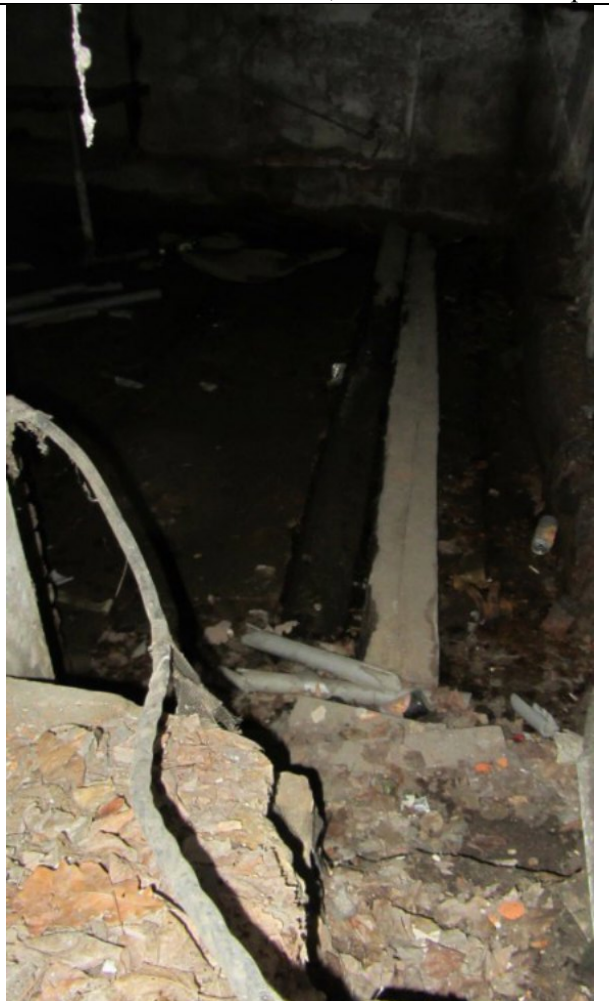
Фото 159. Состояние пом. 1-Н
