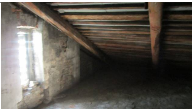
Фото 139. Состояние пом. 1 н.ч.
