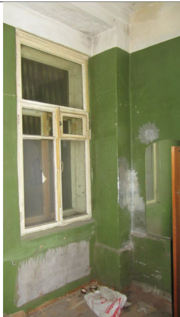
Фото 55. Состояние ч.п.3 пом. 4С-Н
