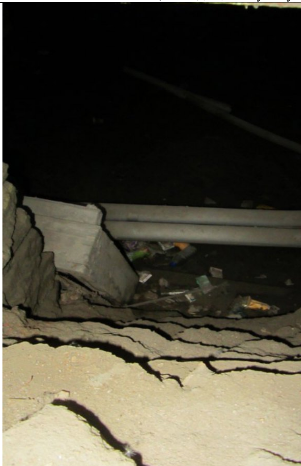
Фото 165. Состояние пом. 2-Н
