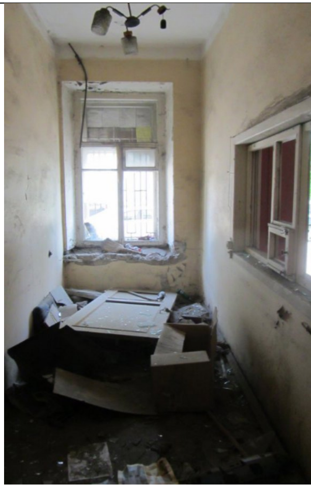
Фото 58. Состояние ч.п. 13 пом. 3С-Н
