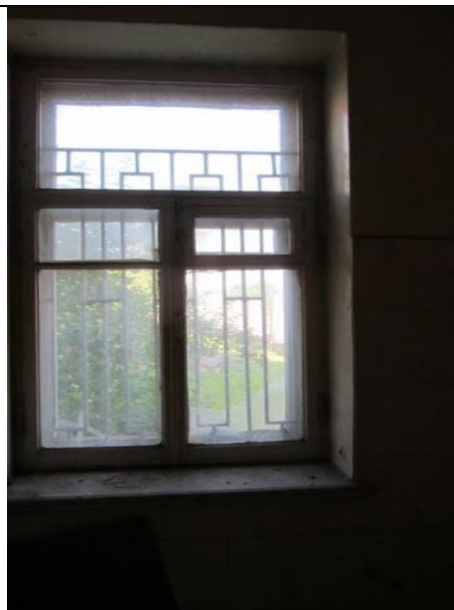
Фото 104. Состояние ч.п.3 пом. 2С-Н
