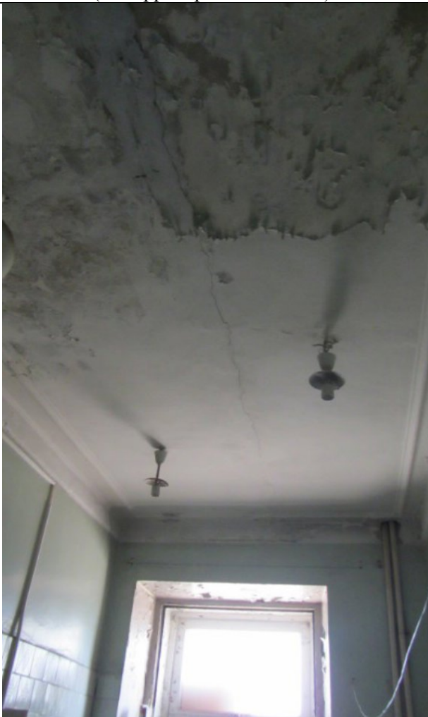
Фото 107. Состояние ч.п.4 пом. 2С-Н
