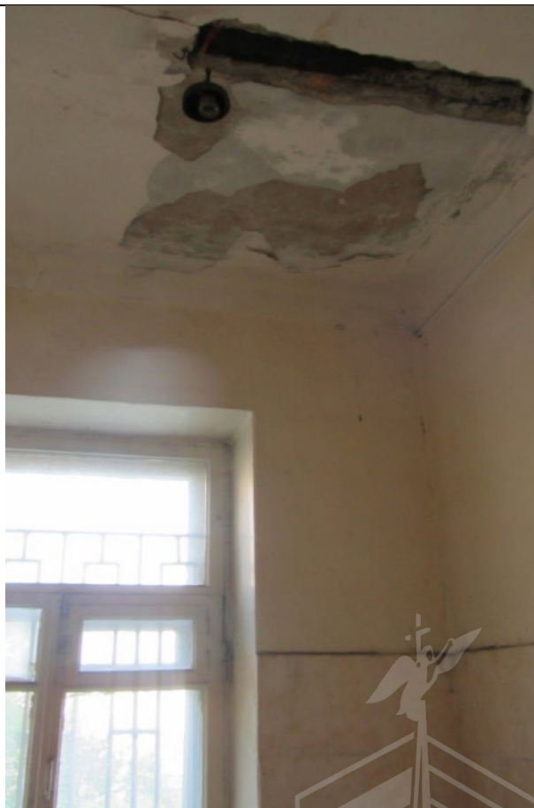
Фото 100. Состояние ч.п.3 пом. 2С-Н
