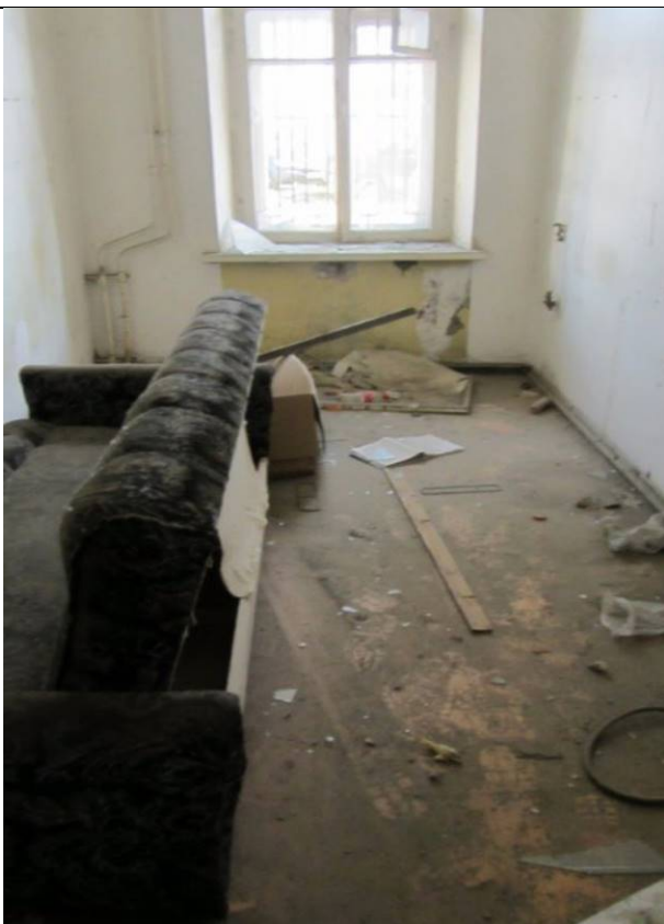
Фото 73. Состояние ч.п. 11 пом. 3С-Н
