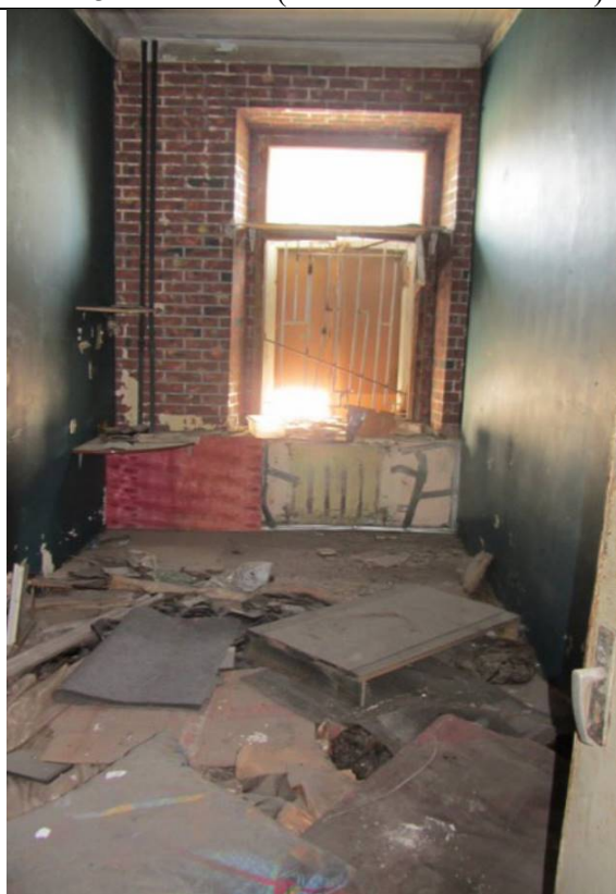
Фото 91. Состояние ч.п.6 пом. 2С-Н
