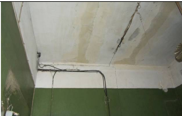
Фото 53. Состояние ч.п.3 пом. 4С-Н
