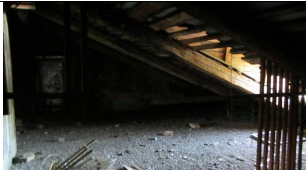
Фото 120. Состояние пом. 1 н.ч.
