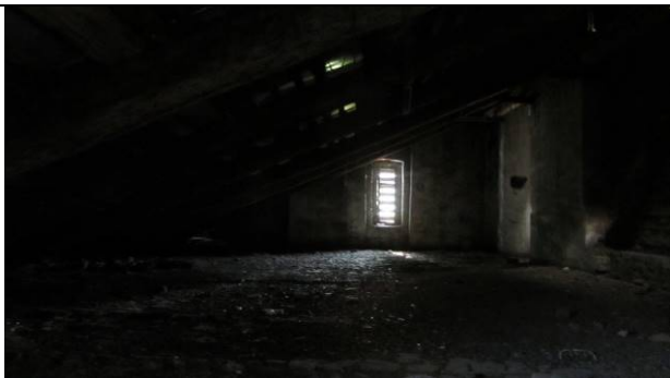
Фото 126. Состояние пом. 1 н.ч.
