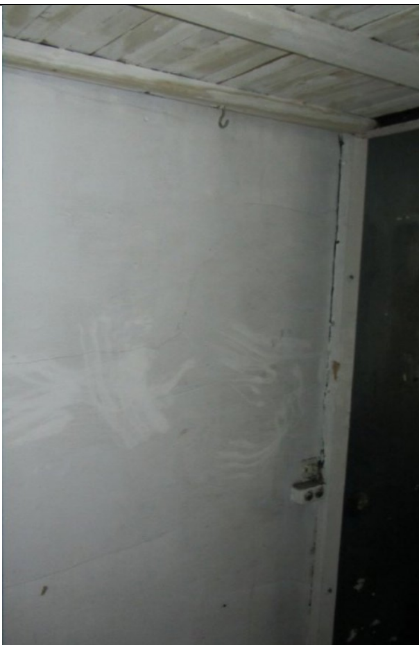
Фото 93. Состояние ч.п.6 пом. 2С-Н
