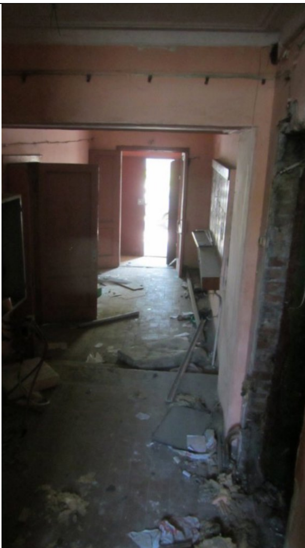
Фото 151. Подход к пом. 1 н.ч. с лестницы №1
