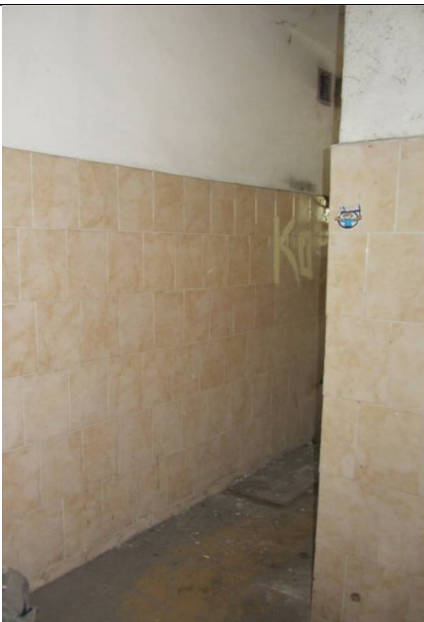
Фото 61. Состояние ч.п. 2 пом. 3С-Н
