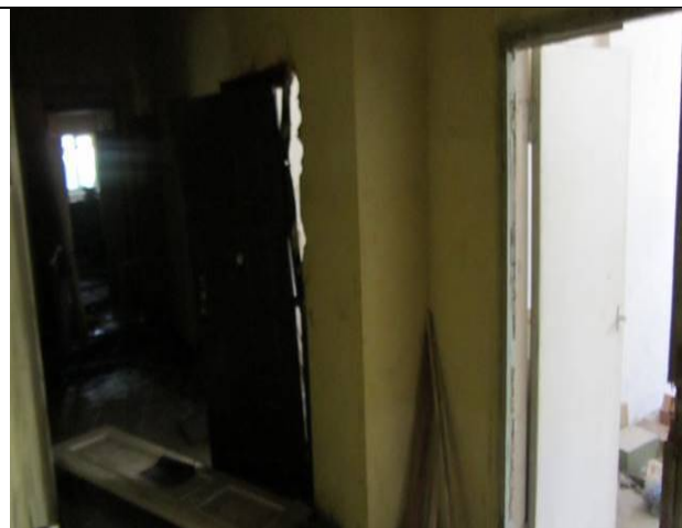
Фото 70. Состояние ч.п. 1 пом. 3С-Н
