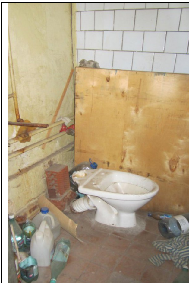
Фото 47. Состояние ч.п.2 пом. 4С-Н
