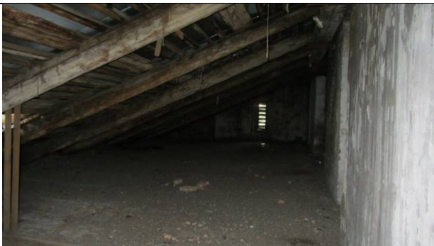
Фото 123. Состояние пом. 1 н.ч.
