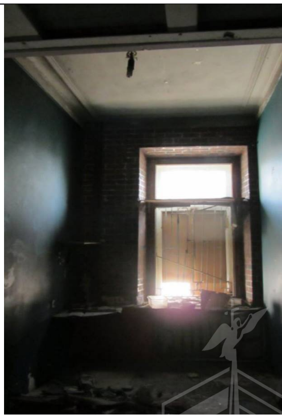
Фото 92. Состояние ч.п.6 пом. 2С-Н
