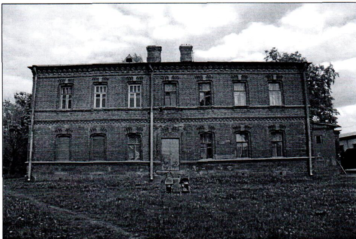
3. Общий вид. Западный фасад
