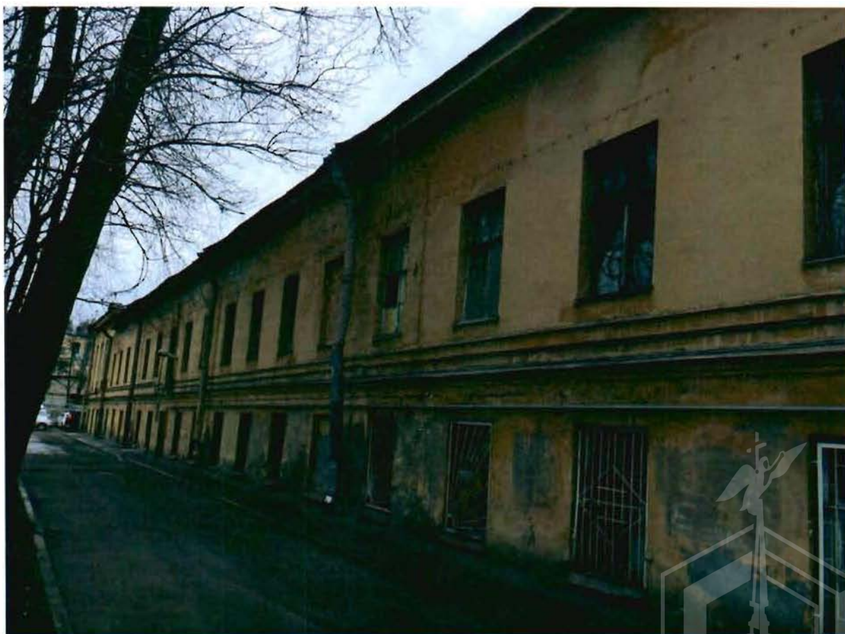
Фото 4. Восточный дворовый фасад.
