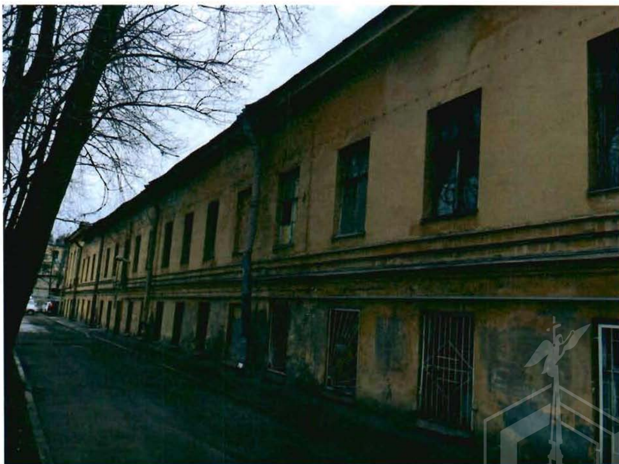
Фото 4. Восточный дворовый фасад.
