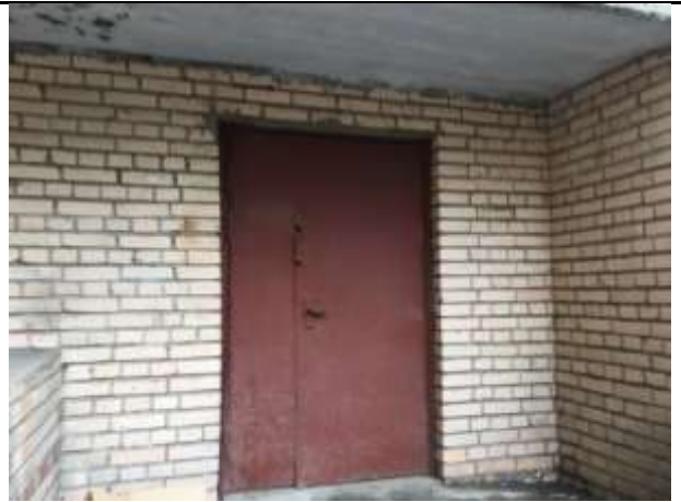
Фото 8: Дверь отдельного входа в оцениваемое помещение со двора
