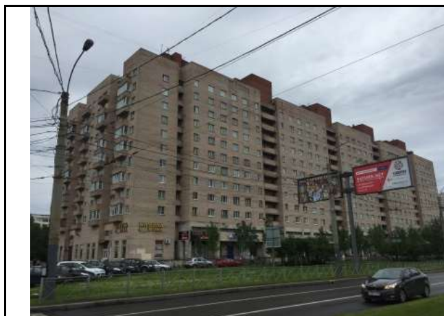
Фото 1: Фасад здания, в котором расположен объект оценки (с Богатырского проспекта)
