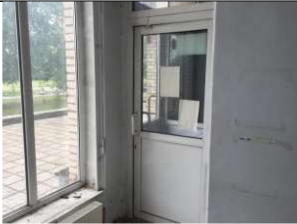
Фото 13: Ч.п.2, вид на ч.п.1 и дверь входа в оцениваемое помещение с улицы (вид изнутри)
