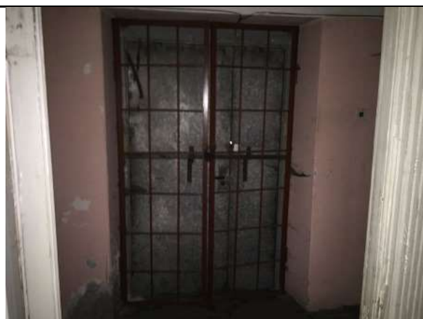
Фото 20: Ч.п.8, дверь входа в оцениваемое помещение со двора (вид изнутри)
